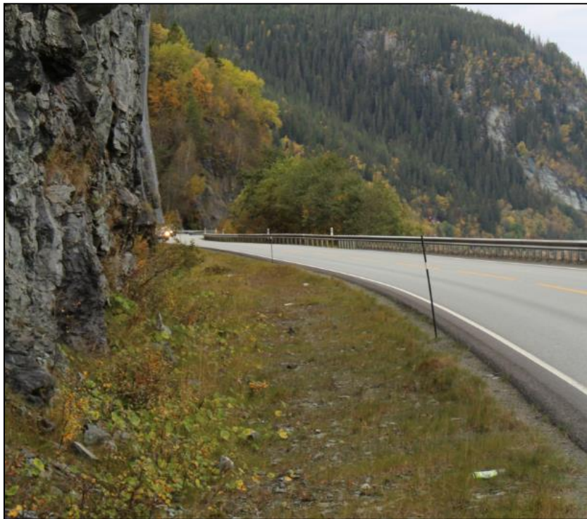
Figur 1.22 Bred veigrøft langs Fylkesvei 715 som hindrer stein å havne på veibanen (Foto: Erlend Alvestad).
