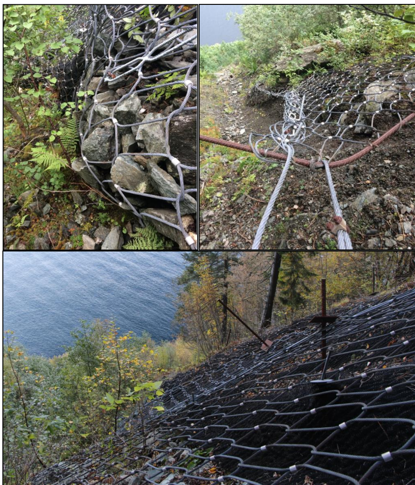
Figur 1.18 Bruk av wirenett langs Fylkesvei 715 for å stabilisere steinblokker i ur (Foto: Erlend Alvestad).
