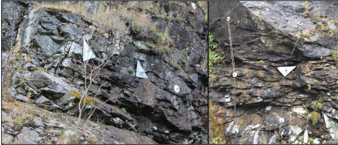
Figur 1.17 Bruk av forankringsbolter og fjellbånd langs Fylkesvei 715 for å forankre og stabilisere blokker med markerte baksprekker og glideplan (Foto: Erlend Alvestad).
