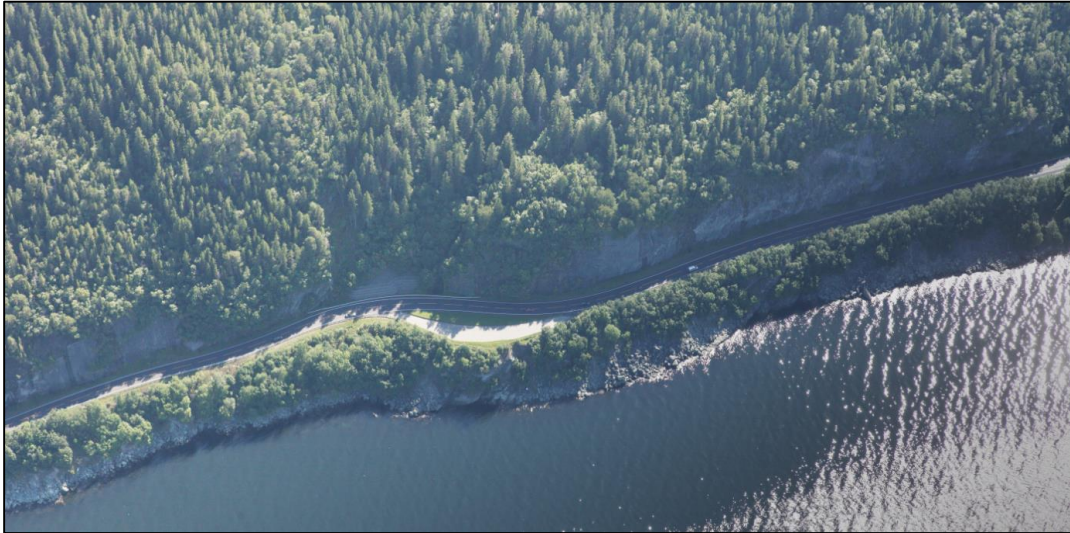
Figur 1.2 Flybilde av det østlige området som domineres av lavere skråninger og høyere veiskjæringer (Trondheim kommune, 2013).
