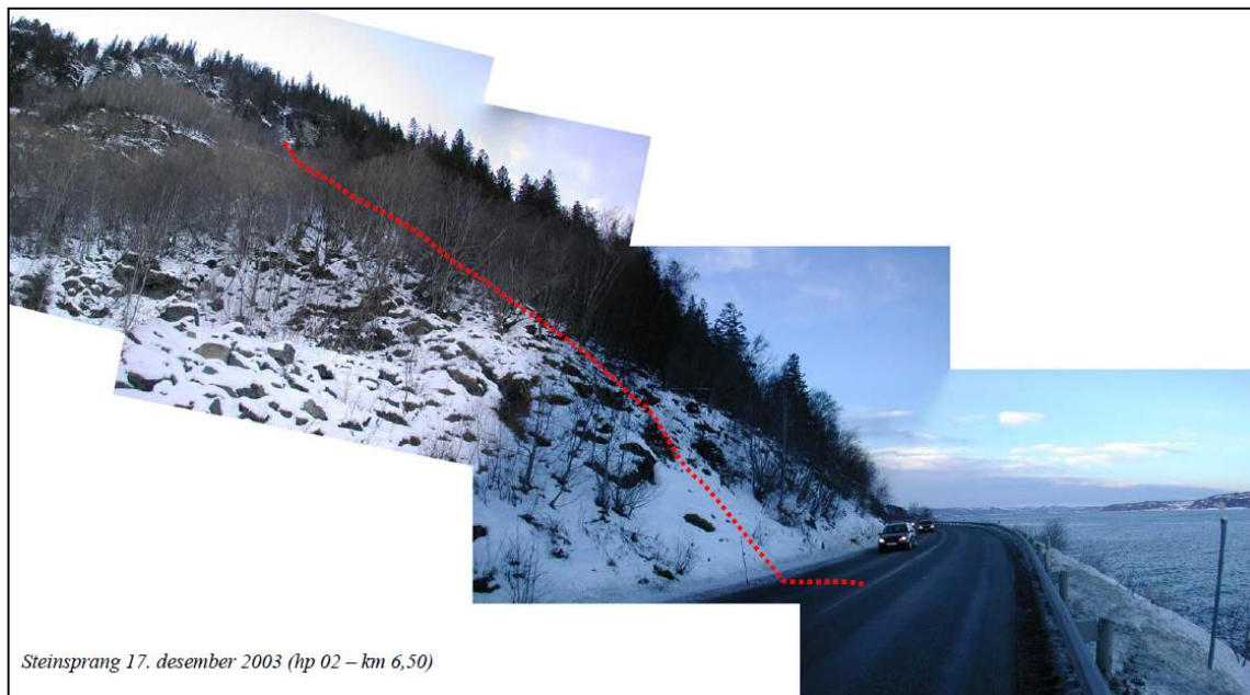
Figur 4.16 Utløpsbanen til steinspranget fra 2003 (Lillevik, 2009).
