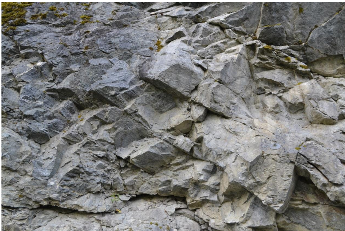
Figur 8-4: Eksempel på bergskjæring der foliasjonen faller mot sør. Bildet er tatt mot øst. (Foto: Chhatra Bahadur Basnet).
