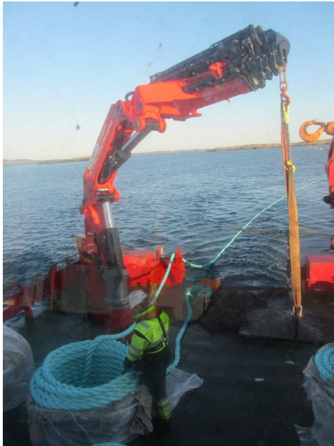
Figur 16 Utsett av et anker
