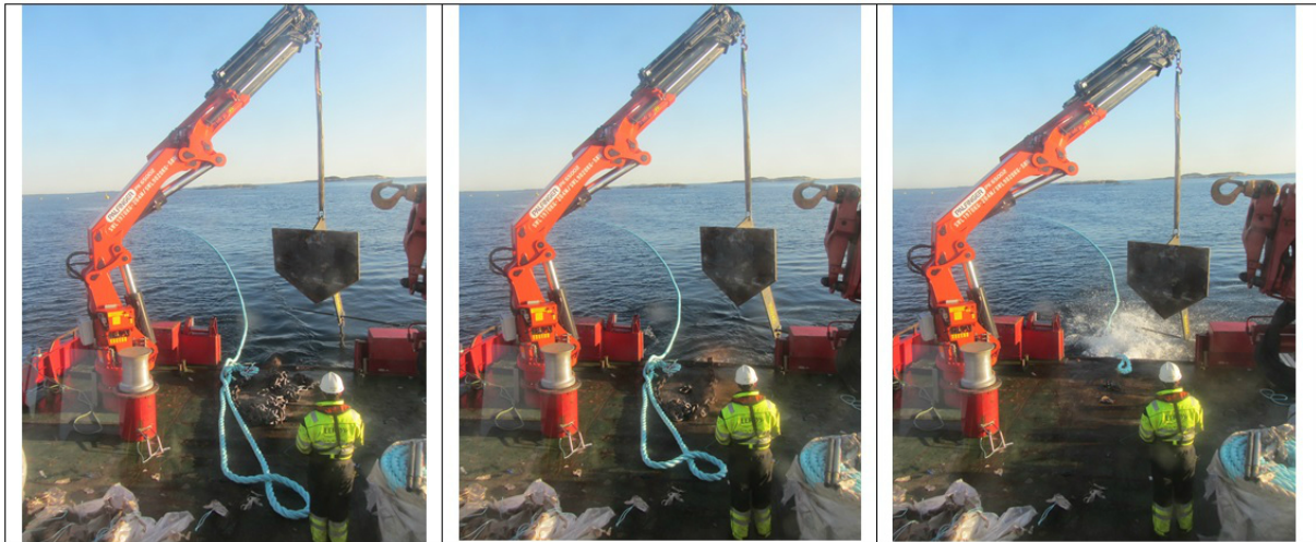
Figur 15 Dumping av kjetting
