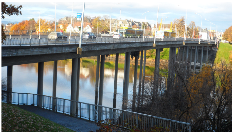
Figur 41: Elgeseter bru, Trondheim
