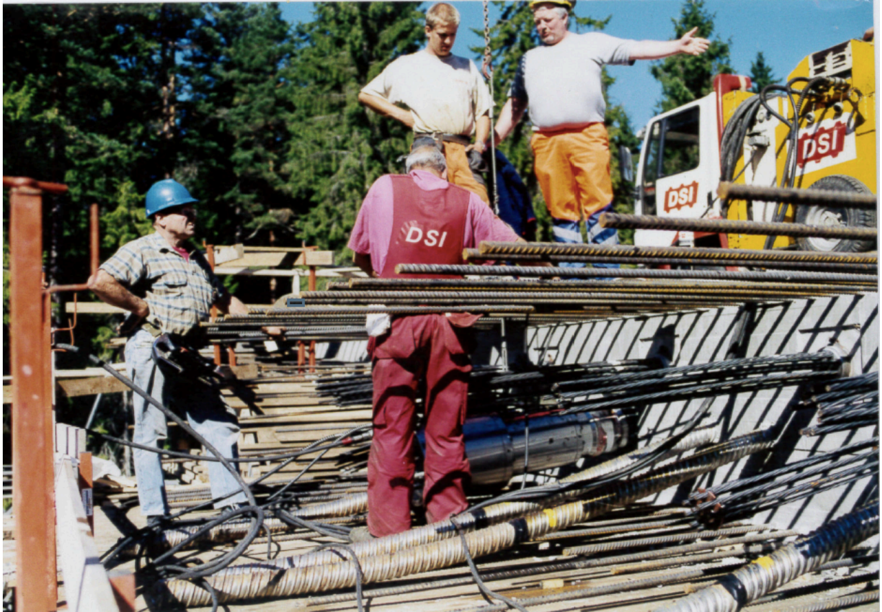
Figur 7: Slakk-og spennarmering på Gulliksrud bru
