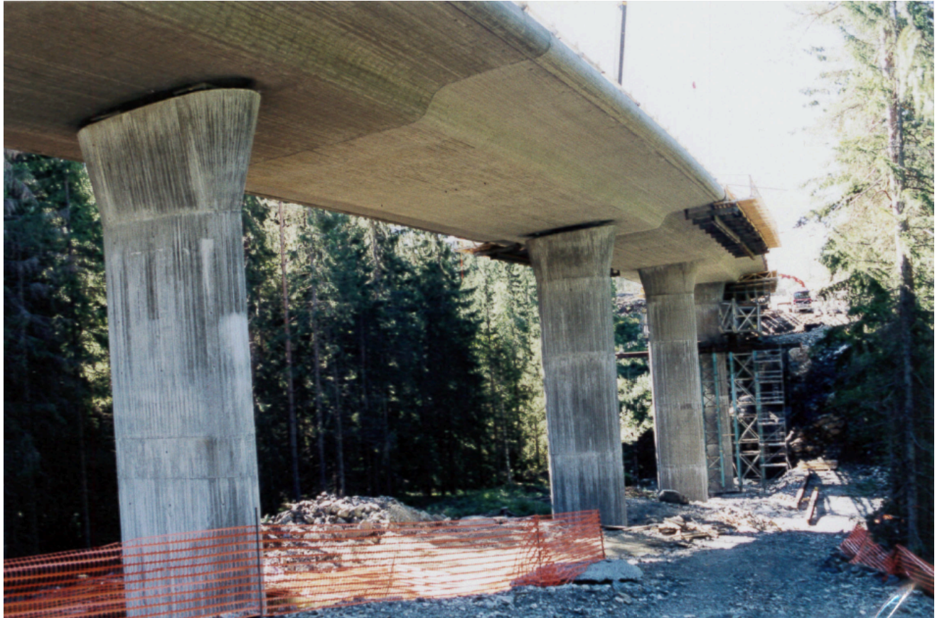
Figur 6: Gulliksrud bru under utbygging
