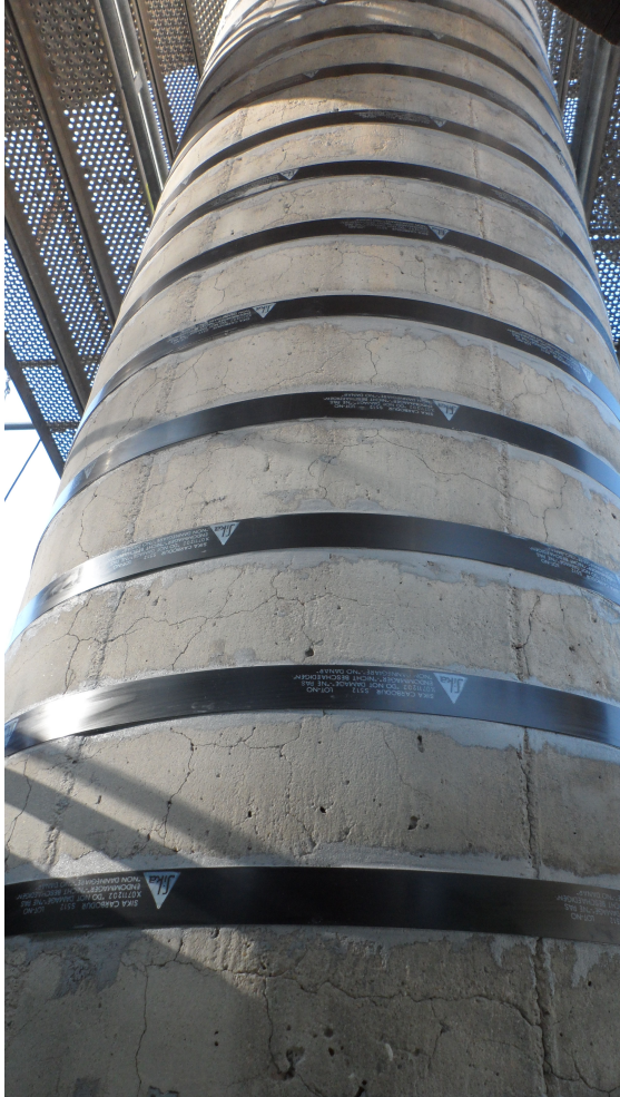
Figur 36: Laminater påført en søyle
