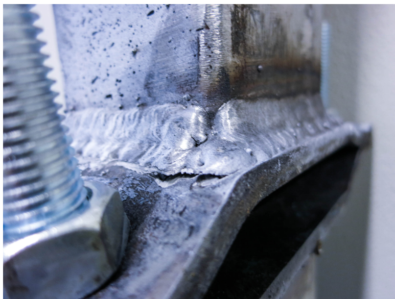
FIGUR 6.15: Sprekkdannelse ved sveis på prøvestykke B1, bilde fra "bakside" relativt til kamera
