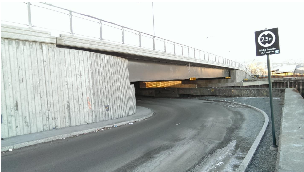
Figur 9-1 – Bildet av Ravnkløpbrua
