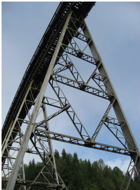
Figur 2-4: Trolldalen Viadukt, pendelpilar
