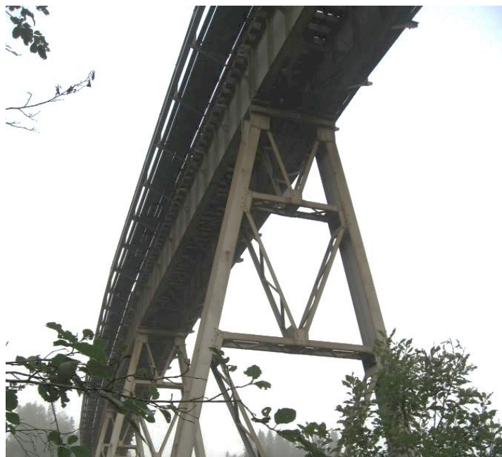
Figur 4-17: Platebærerdekket sett nedenfra
