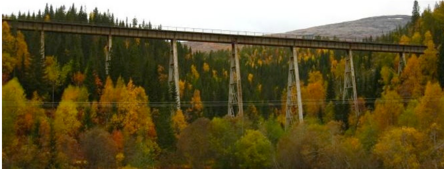
Figur 2-3: Trolldalen viadukt sett fra siden
