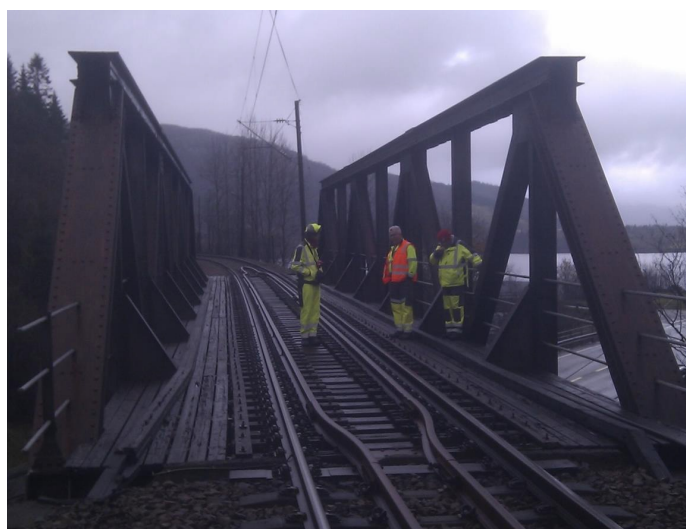
Figur 2-7: Eidselva Bru sett langs jernbanespetet [24]
