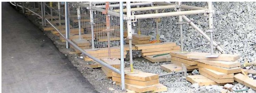
Figur 8.6: Eksempel på en ustabil oppbygging med treklosser. Foto: Adressa.no
