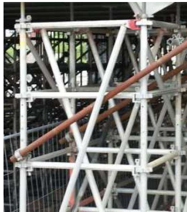
Figur 6.2: Eksempel på avstiving med både Alustar komponenter og stålrør
