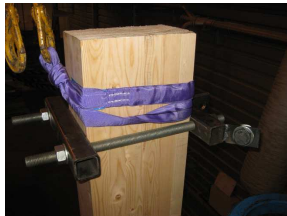
Figur 21: Innfesting av strekkstag i søyletopp.
