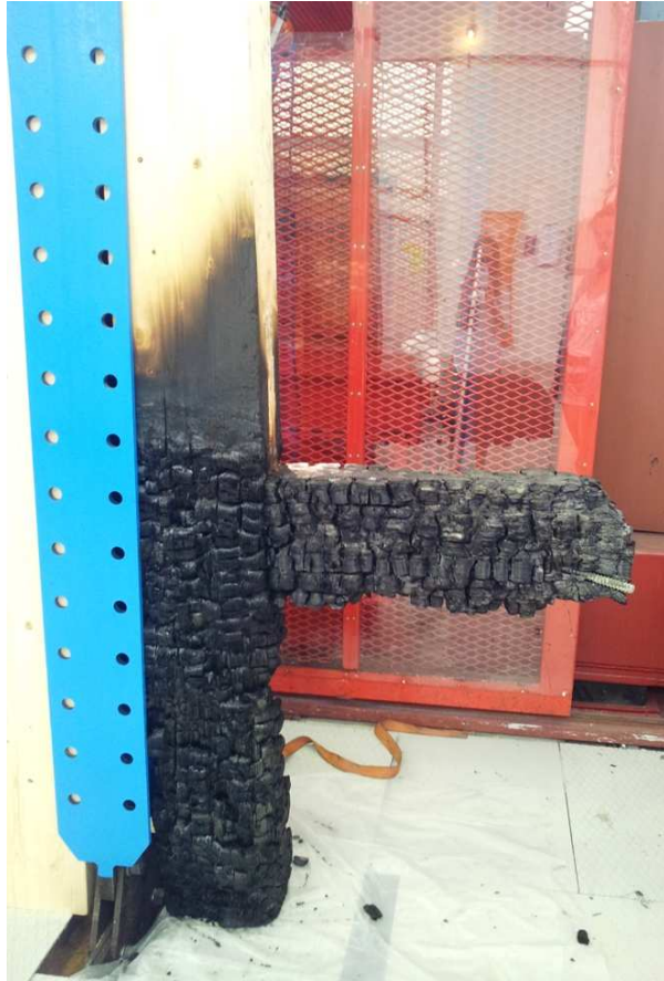
Figur 5.18: Bildet viser forkullet bjelke (test 6) etter å ha blitt utsatt for et brannforløp i over 60 minutt. Foto: Privat.
