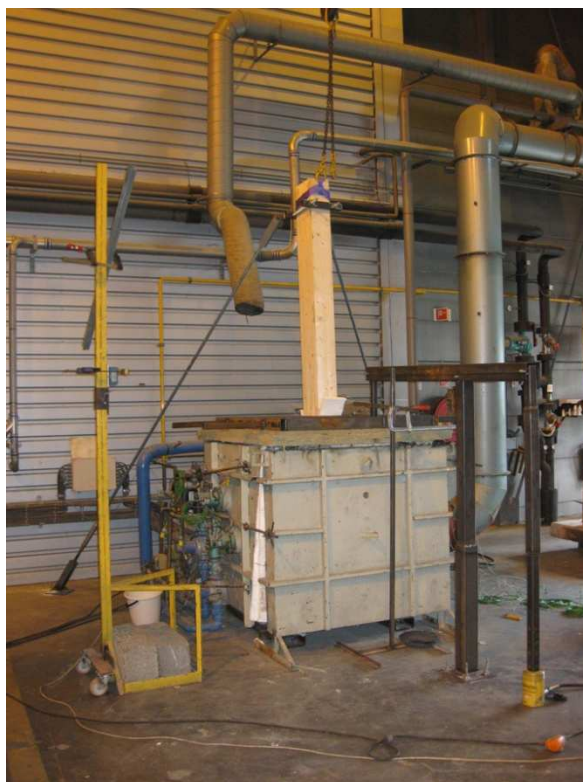
Figur 23: Ferdig montert testsystem. Forskyvningsmåler er vist til venstre i bildet.
