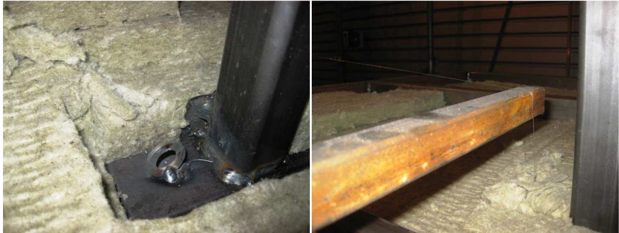
Figur 5.11: Bildet til venstre viser stålringen som forskyvningsmåleren ble festet fast i, mens bildet til høyre viser stålstativets utstikkende arm med forskyvningsmåleren som er lagt over. Foto: Privat.
