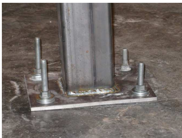
Figur 26: St lplate mot fundament (Detalj D).
