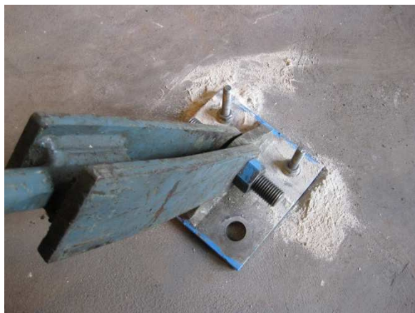
Figur 25: Forankring av strekkstag (Detalj F).
