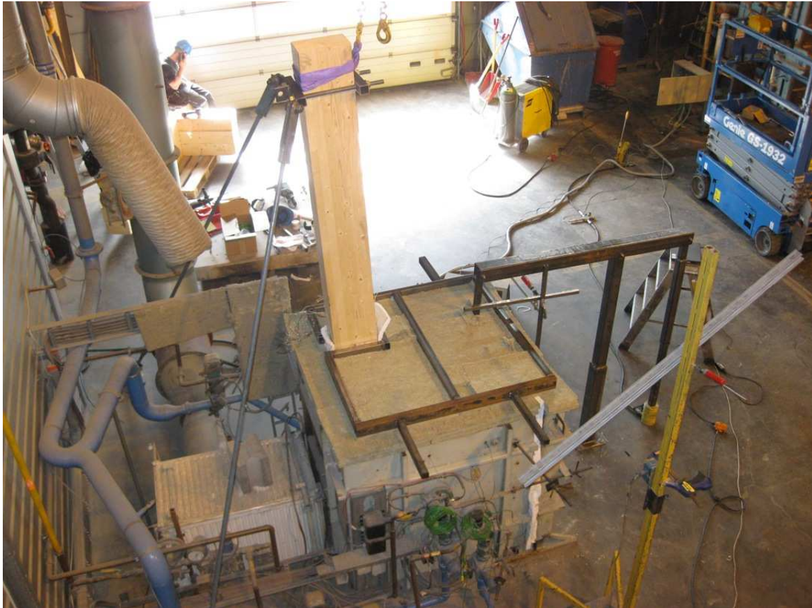
Figur 5.5: Bildet viser ferdig montert testforbindelse i pilotovn. Til høyre for ovnen er det montert et stålsystem som skal påføre bjelken punktlast. Plasseringen av avstivende strekkstag er vist til venstre i bilde. Foto: Privat.
