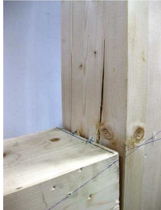
Figur 4.26: Bildet viser test 2 etter at forbindelsen hadde gått til brudd. Foto: Privat.
