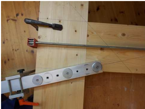
3. Montering av vinkel over opptegnet strek for skruelassering.
