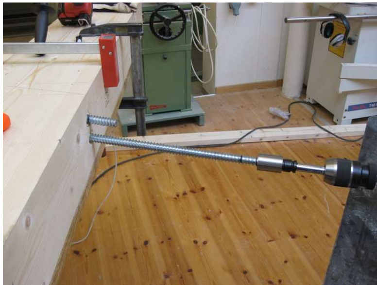
Figur 4.6: Bildet viser innskruing av skruer. Skrumaskinen ligger på et rullebord til høyre i bildet. Foto: Privat.
