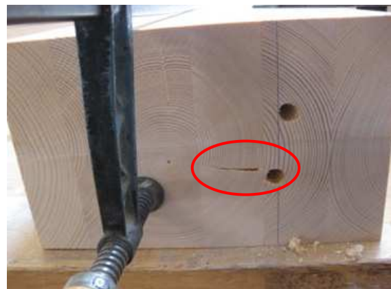
Figur 2: Bildet viser en tydelig sprekk i nærheten av skruerhull øst. I tillegg viser bildet at forborede hull avviker noe fra hverandre. Foto: Privat.
