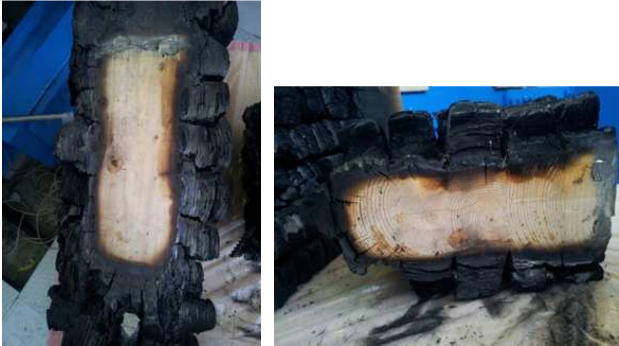
Figur 5.32: Bildet til venstre viser forkulling av søylen i snitt 1-1, og bildet til høyre viser forkulling av bjelken i samme snitt. Foto: Privat.
