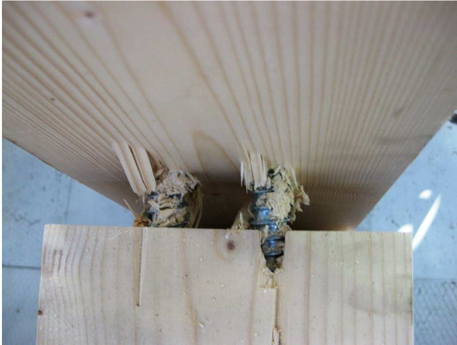
Figur 4.23: Bildet er tatt ovenfra, noen minutter etter at testforbindelse 2 allerede var gått til brudd. Bildet viser tydelige tegn til at skruene har forflyttet seg i forhold til treet. Foto: Privat.
