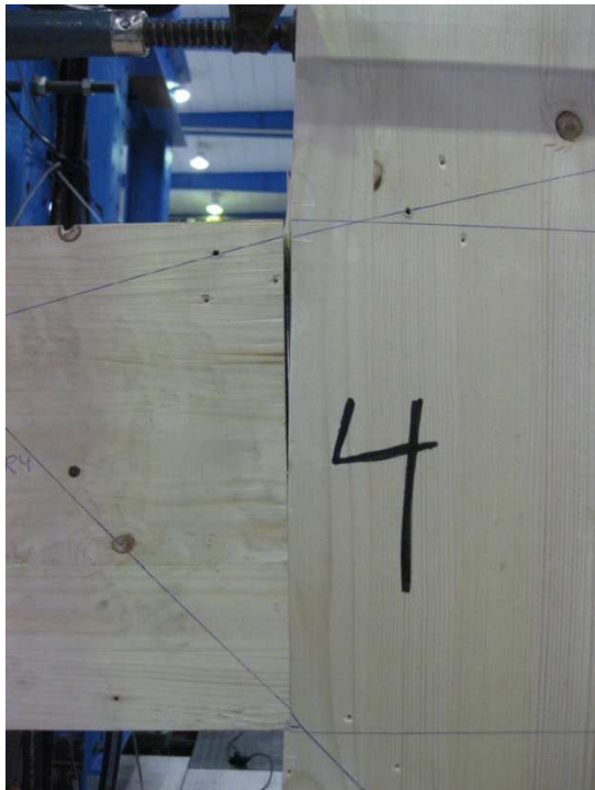
Figur 16: Åpning mellom bjelke og søyle.
