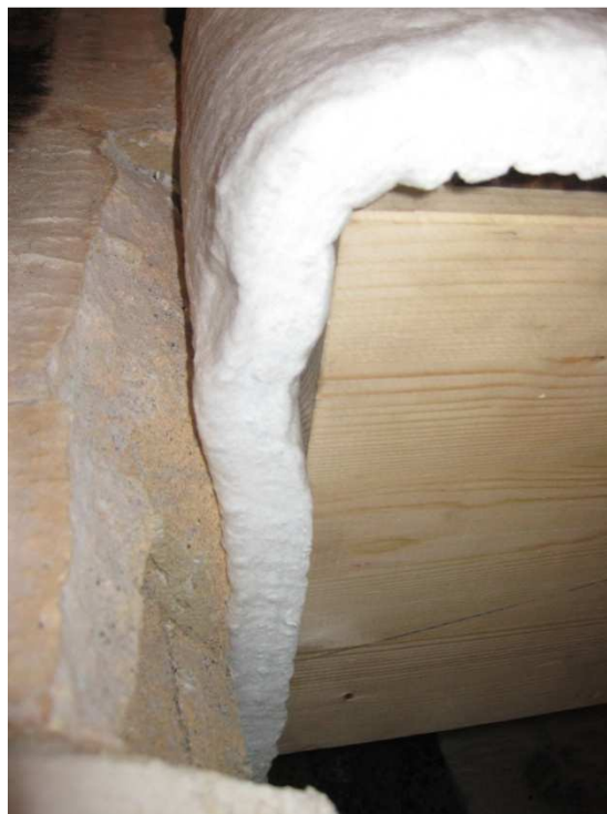
Figur 19: Brannisolering av bjelkens ende.
