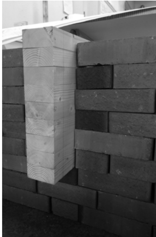
Prosessbilde 1:1 workshop med teglstein Innfesting av limtrebjelke
