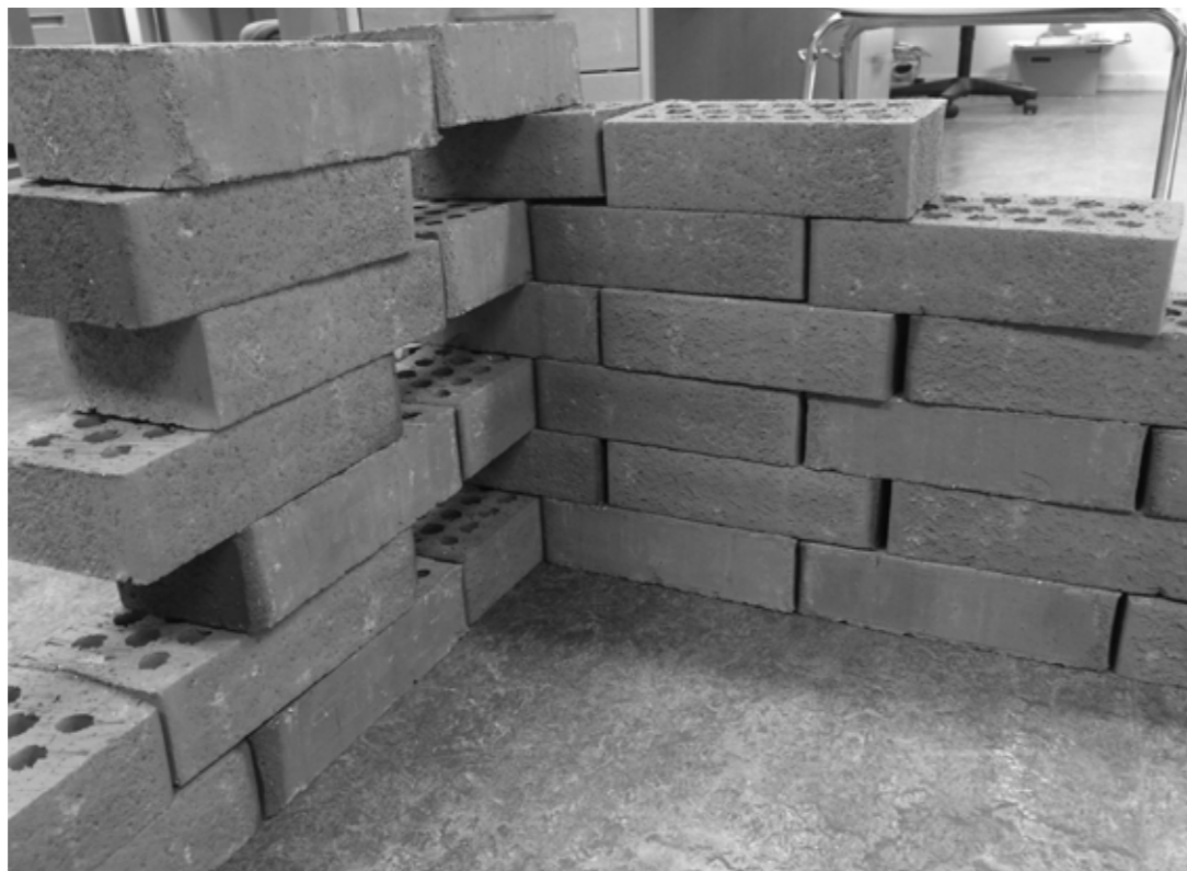
Prosessbilde 1:1 workshop med teglstein Oppbygging av hjørne
