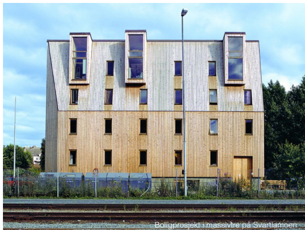
Boligprosjekt i massivtre på Svartlamoen
