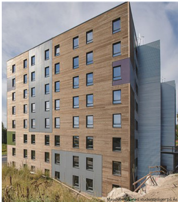
Massivtrehus med studentboliger på Ås
