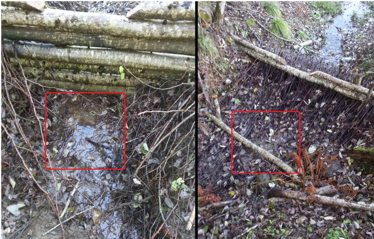
Figur 31: De røde rammene viser hvor det meste av sedimentene er avsatt. Stottdam Storlykkja til venstre, kvistdam Storlykkja til høyre. Bildene er tatt 27.oktober 2014.
