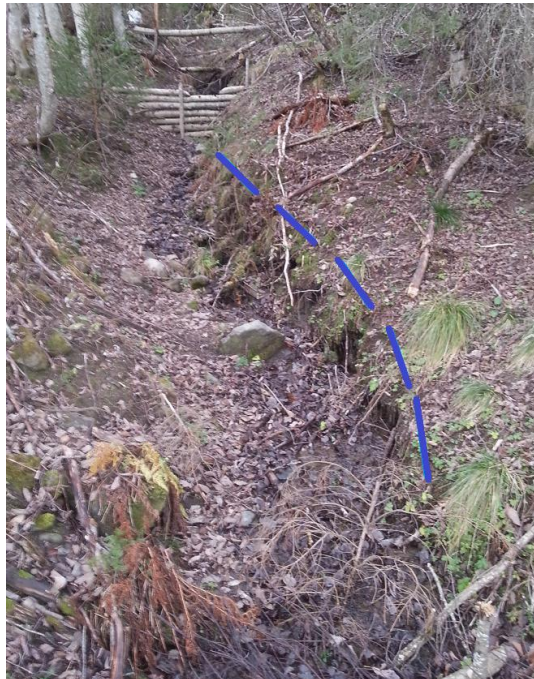
Figur 10: Kanalen mellom stokkdam Storlykkja og kvistdam Storlykkja. Den stiplede linjen angir hvor vannstrømmen gikk 10.november 2014.
