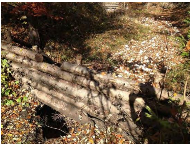
Figur 4: Erosjonshull nedstrøms en stokkdam i Slovakia(foto Braskerud et al. (2014)).
