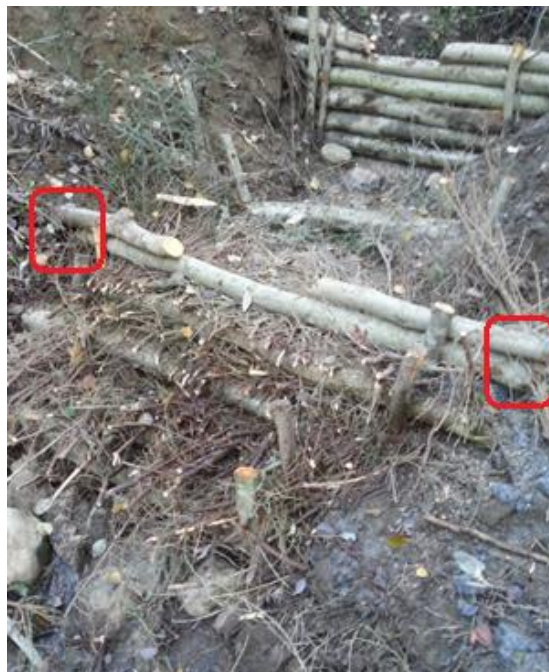
Figur 16: Kvistdam og stokkdam som ble bygget i Engan 14. oktober. Det røde markerer de stokkene som ikke er forankret i jorda. Bildet er tatt 20.10.2014.
