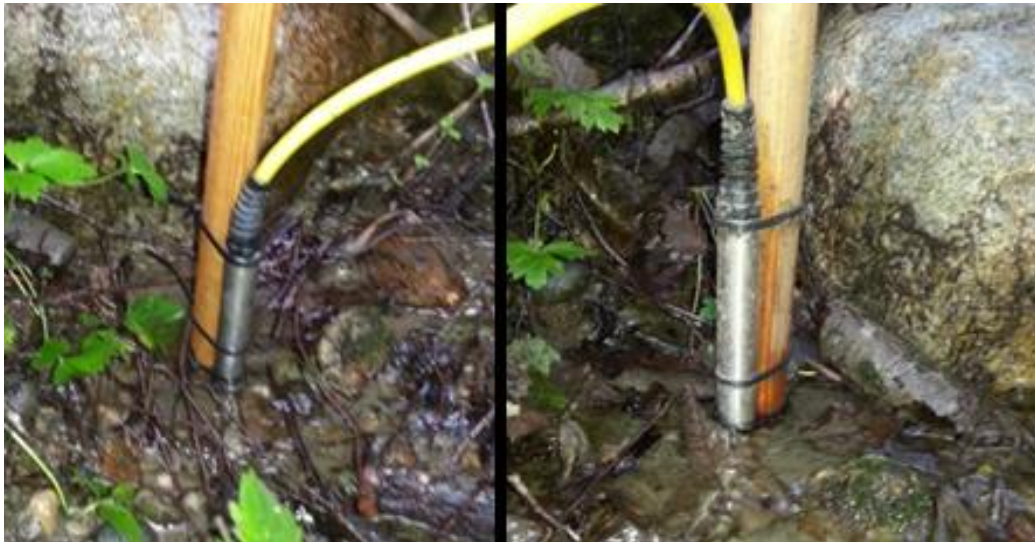
Figur 20: Bilde av vanntrykkloggeren lokalisert oppstrøms kvistdam Storlykkja. Bildet til venstre er tatt 4.september, bildet til høyre er tatt 30.september. Den nederste stripsen har i løpet av perioden blitt dekket av sedimenter og vegetasjon.
