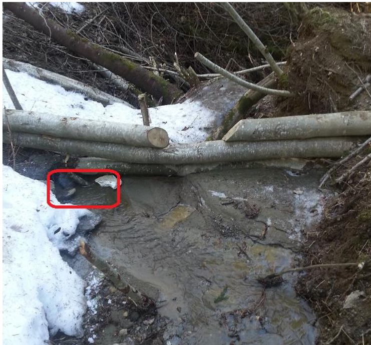
Figur 34: Nedre stokkdam Engan. Rød markering viser hvor vannstrømmen gikk. Bildet er tatt 13.03.2015
