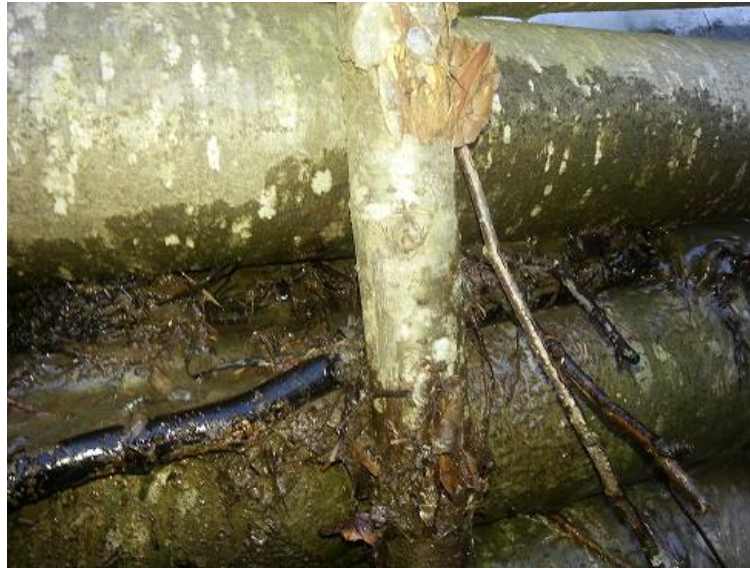
Figur 35: Bildet er tatt på nedstrøms av nedre. Tydelig vegetasjon/kvister mellom stokkene. På høyre side kan man se hvor vannstrømmen går. Bildet er tatt 13.03.2015.
