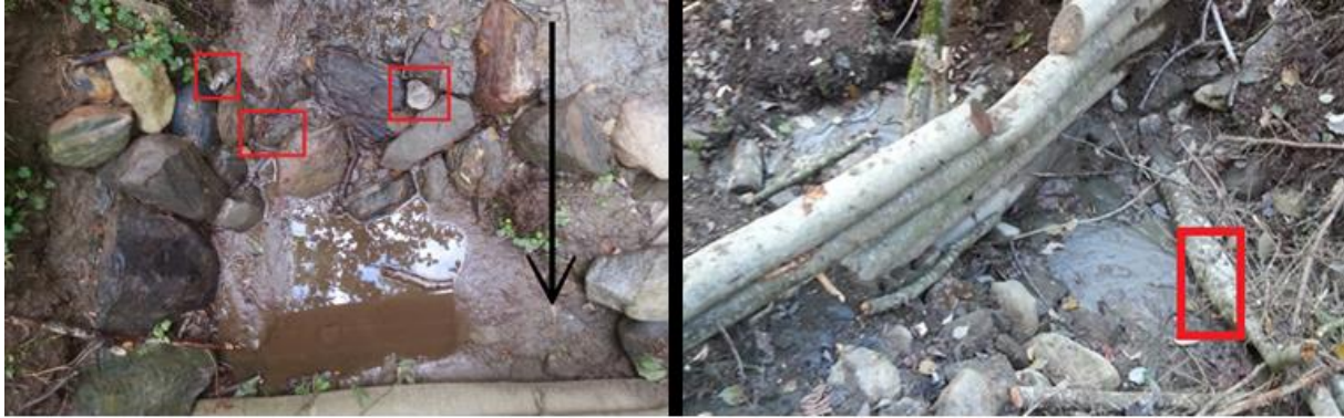
Figur 25: Bilder fra nedre stokkdam Engan. Steinene innenfor det røde er PIT-tag merkede. Pilen angir strømretningen. Bildet til venstre er tatt 4.september. Bildet til høyre er tatt 16.oktober.
