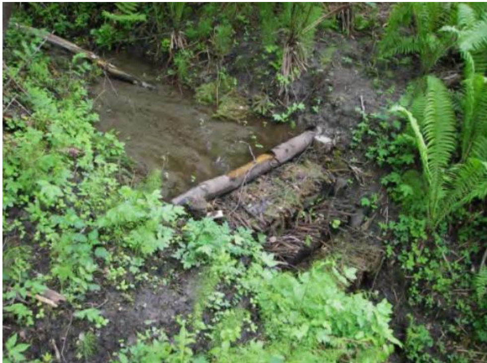
Figur 6: En kvistdam som ble bygget i 2012 på Minnesund. Kvistdammen er fylt opp med sedimenter til den øverste stokken (foto Braskerud et al. (2014)).
