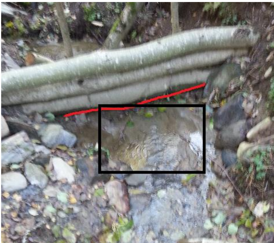
Figur 32: Den røde streken markerer toppen på den nederste stokken i stokkdam Engan. Den svarte rammen markerer lokasjonen på sedimentavsetningen. Bildet er tatt 30.09.2014.
