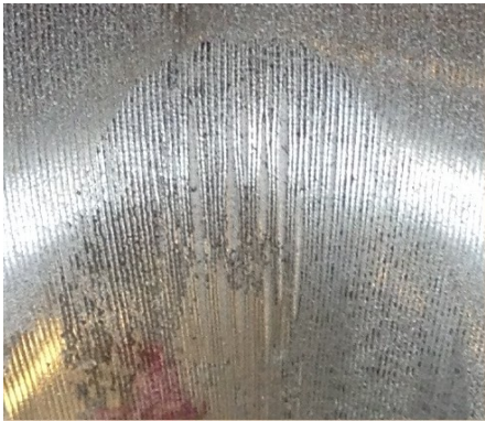
(d) Close-up of Pipe 2.
