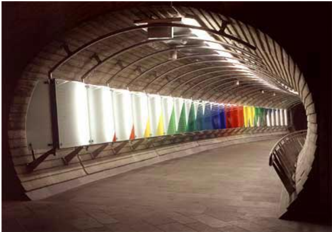
Nationaltheatret Stasjon. Oppgang vest – 1999. Ny passasje til flytoget Arne Eggen Arkitekter A/S ( http://www.aea.no/nationaltheatret/ )
