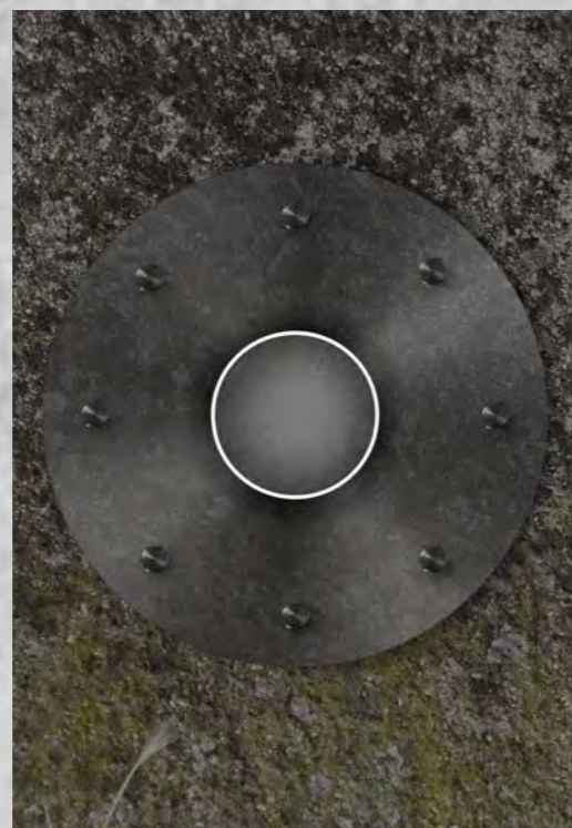
Detalj plan Innfesting av lyssøylor i betong Målestokk 1:10
