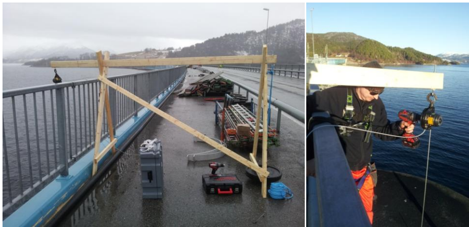
Figur 3.24: Løftebukken ble satt opp, og alt tungt utstyr kunne dermed heises ned med vinsj
