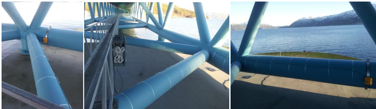
Figur 3.30: Kabeltrekking til akselerometre
