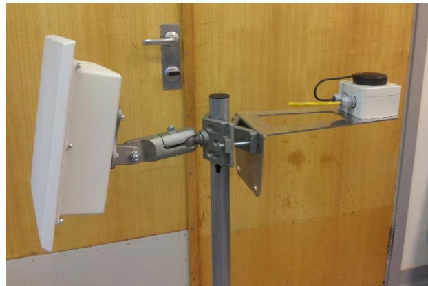
Figur 3.10: Montering av WiFi antenne og GPS mottaker
