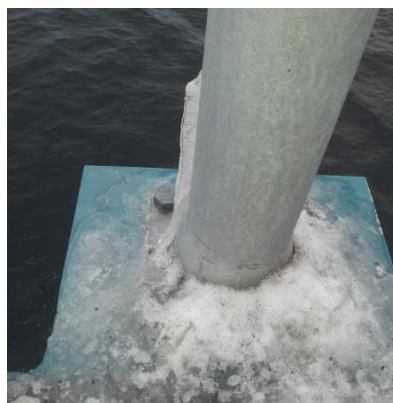
Figur 5.29: Fotplate til lysmast på Bergsøysundbrua
