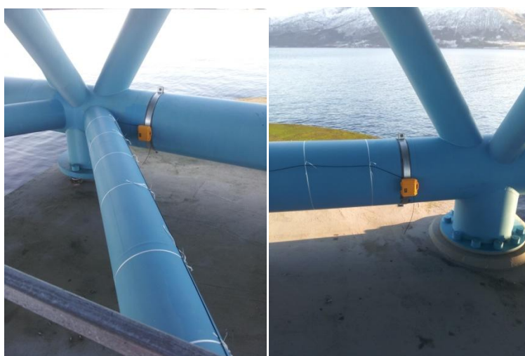
Figur 3.28: Montering av akselerometerkasser på klemmene
