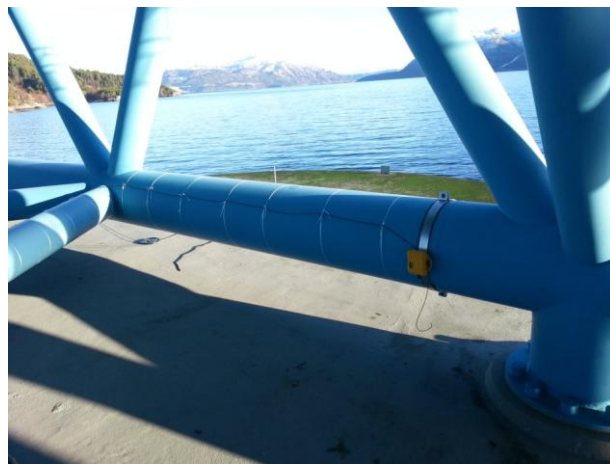
Figur 7.17: Montering av akselerometre på Bergsøysundbrua
