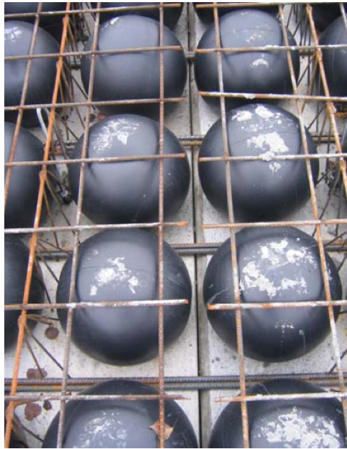
Figur 6.6: Armeringsutførelse [34]
