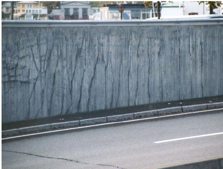
Figur 5.2: Rissutvikling på grunn av ytre fastholding[66]
