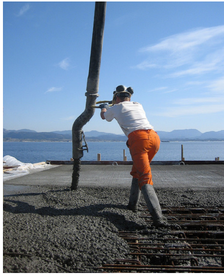
Figur 6.2: Betongstøp [foto: Veidekke]
