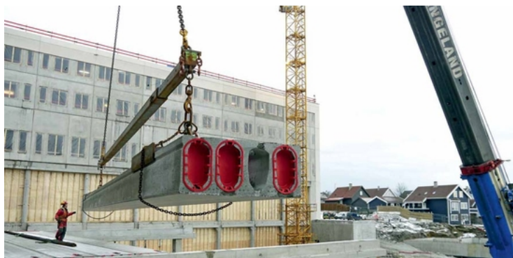
Figur 6.7: Hulldekker heises på plass [veidekke]
