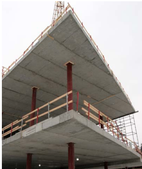
Figur 6.3: BubbleDeck åpner for lange spenn i to retninger [34]
