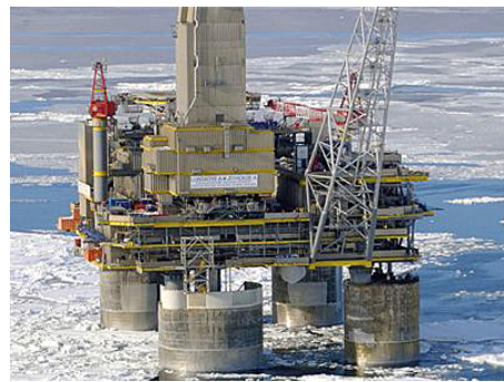
(d) Installed on platform
