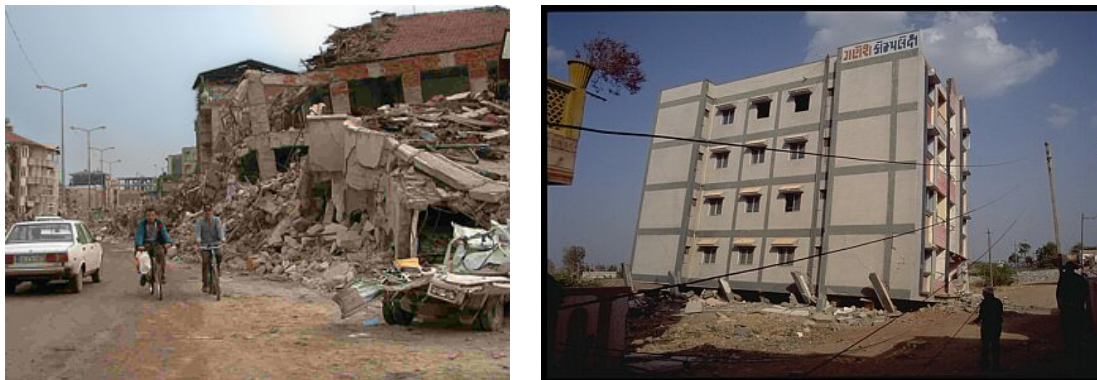
Figur 1.3: Kollaps i lett armert teglsteinsbygning fra Tyrkia i 2009 (t.v.) [23] og “soft story” kollaps fra India i 2001 (t.h.) [7].
