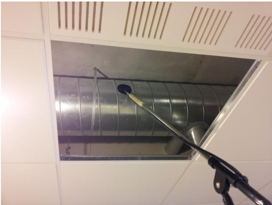
Figur 4.2: Måleoppsett for måling av lydeffekt før avgrening
