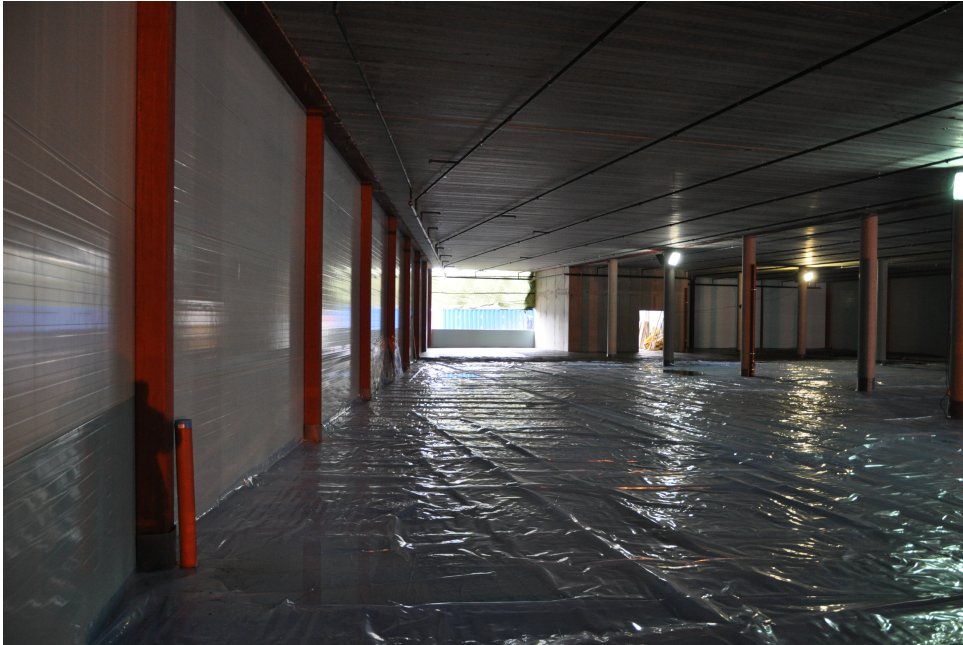
Figur 1.2: Alt er klargjort for gulvstøp
