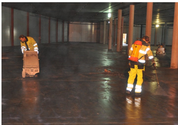
(c) Kutting av rissanviser og påføring av membran
