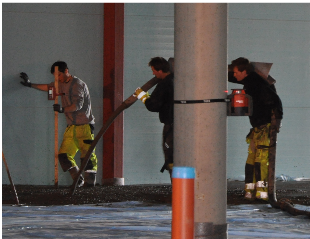
Figur 2.4: Gulvstøping ved hjelp av laser
