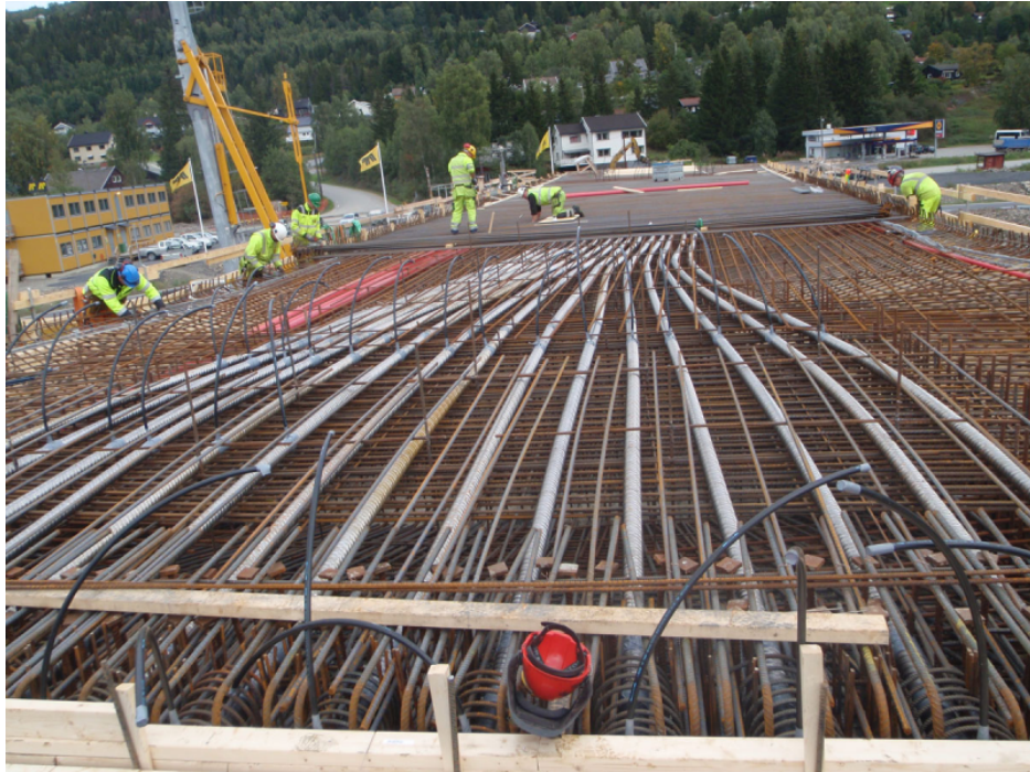
Figur 5.2: Armering i brudekke, Tingberg bru. Foto: Statens Vegvesen [11]
