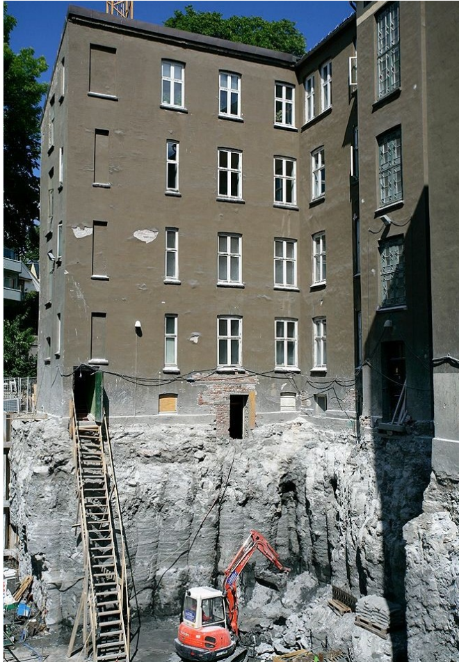
a) Underpining av Inkognitogaten 33, Oslo etter frigraving av jetpelene.
