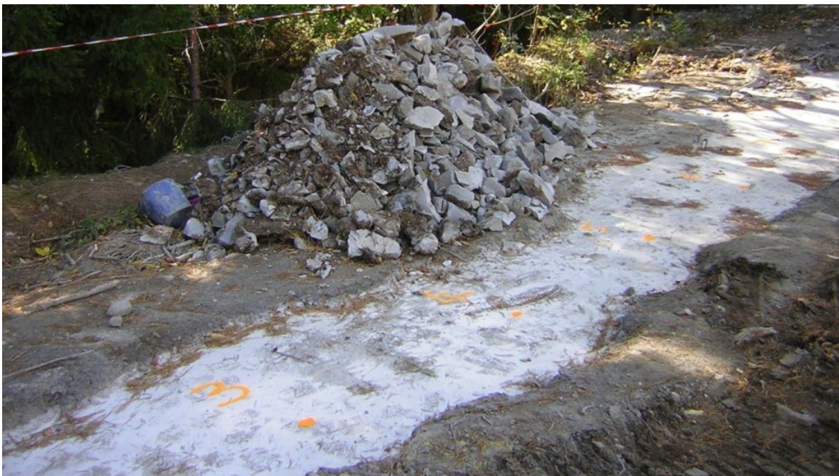
Figur 2-6: Figuren viser toppen av en tetningsskjerm av jetpeler ved Birkeland Vannverk, Birkenes. Jetpelene er satt til fjell og injisert i etterkant for å tette kontaktsonen mellom pel og fjell, samt sprekker i grunnfjellet.
