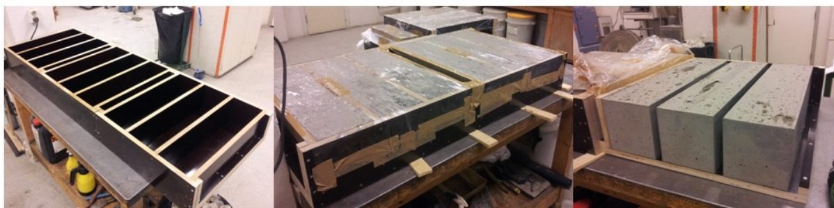
Figur 3.6: Utstøping av bjelker
