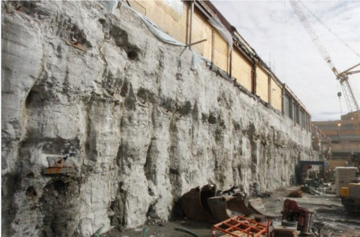
Figur 2.5: Ved utbyggingen av Storo Storsenter i Oslo, ble denne jetpelrekken utnyttet for sikring av byggegrop, underpining av eksisterende bygg og som bærende vegg i kommende parkeringskjeller. Jetpelene er uarmerte og derfor stagforankret for å redusere bøyemomentet.
