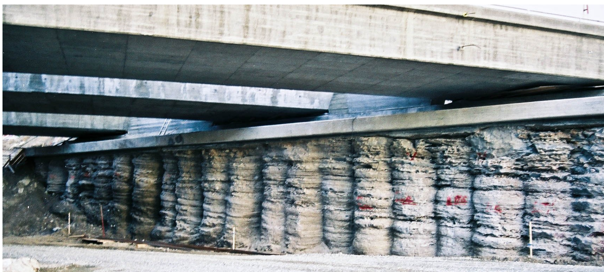
Figur 2.1: Jetpeler benyttet som landkar for to jernbanebruer og en veibru i Porsgrunn, Telemark. Det ble til sammen satt 188 jetpeler i tre rader på begge sider av overgangen.
