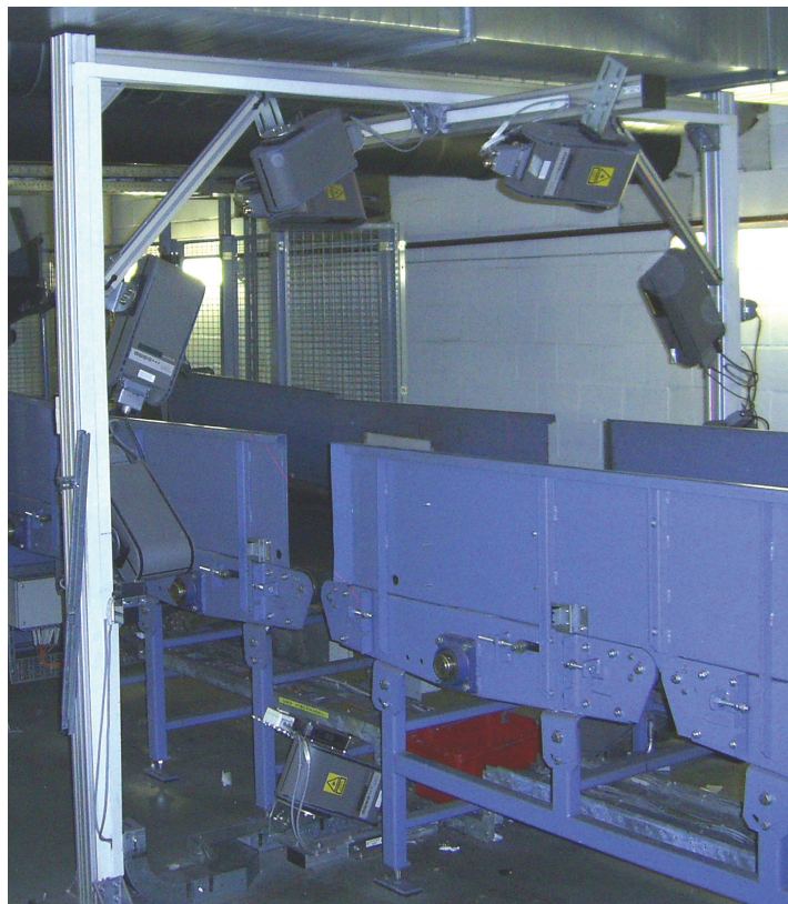
Figur 3.2: Datalogic strekkodelesestasjon plassert på Oslo Lufthavn Gardermoen.
