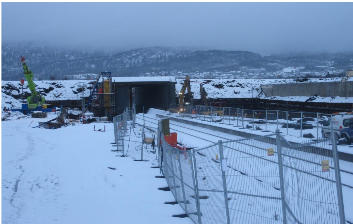
Figur 1 Påbegynte anleggsarbeider, eksisterende kulvert over sporet
