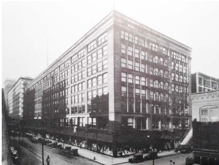
Illustrasjon 23. Second Leiter Building 1888 av William Le Baron Jenney. Kostof, Spiro, A history of Architecture, Settings and Rituals , Oxford University Press 1995. s. 660.
