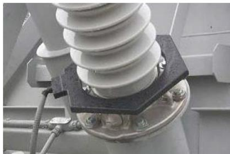
Figur 4-14: Gjennomføring med RC [23]
