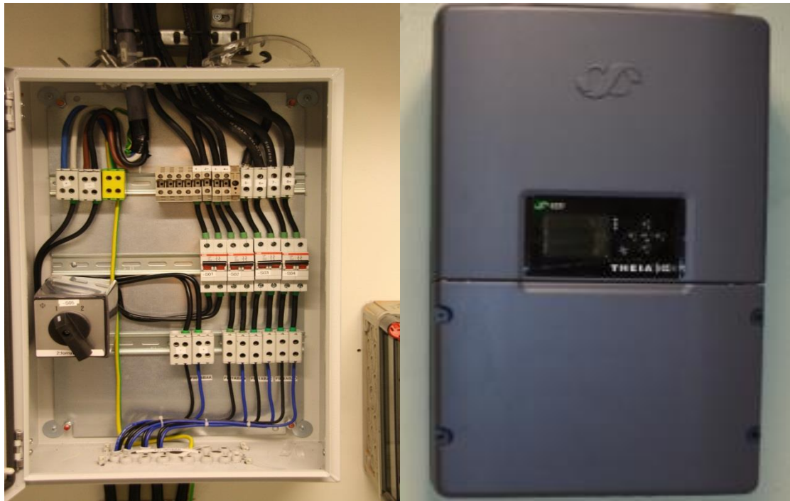
Figur 67. Kombinasjonsboksen og Theia HE-t 2.0 vekselretter[17]
