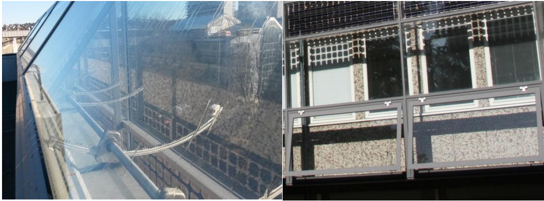
Figur 58 viser ventilasjonsvindue øverst og nederst i fasaden.[17]
