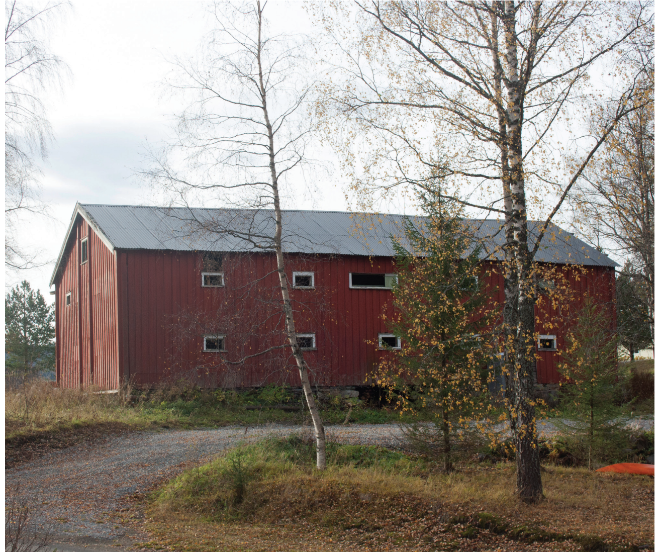
Bilde av storbrygga tatt fra kaien i Putten. Man ser krypkjelleren som blir dannet av fundamentene til bygget. 15
