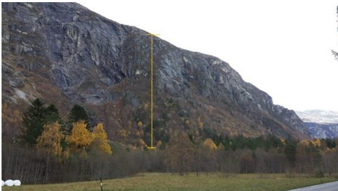
Figur 6-28 Omtrentlig plassering av profil 8, ender i området for påhugg ved Rygg (foto: Marie Drågen Belland)
