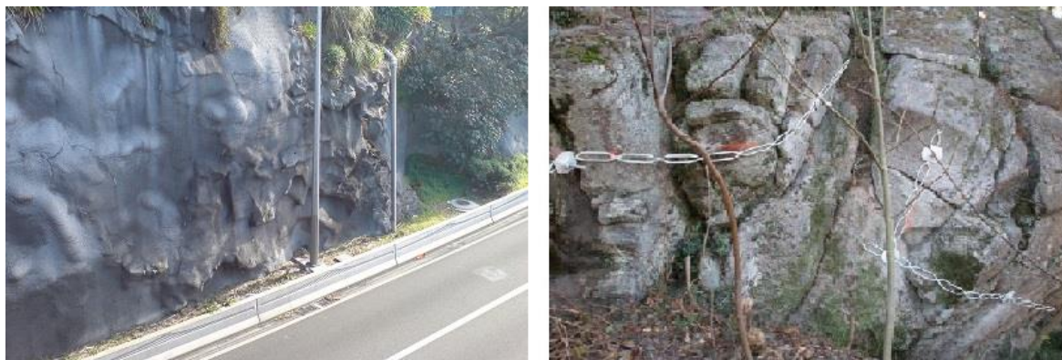
Figur 3-5 Høyre: Sikring med sprøytebetong på vegskjæring (fra wikipedia.no, 2013). Venstre: Fjellbånd som sikring for ustabile enkeltblokker (Bjordal, 2011).
