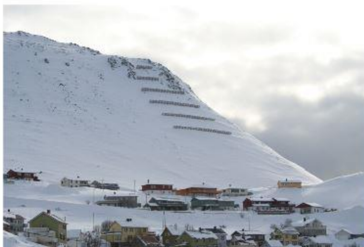
Figur 4-17 Støtteforbygninger, Honningsvåg. Sikrer både veg og hus (Foto: Jan Otto Larsen i Håland, 2012).
