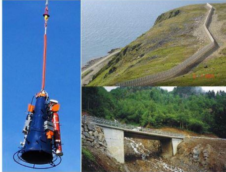
Figur 4-19 Høyre: DaisyBell. Øverst venstre: Snøskjermer. Nederst venstre: Bru over skredløp. (Håland, 2012).
