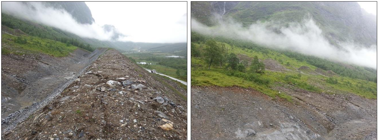
Figur 4-16 Kjegler i kombinasjon med voll på fv60 Strandadalen, 2013 (Foto: Kari Linn Søreide).
