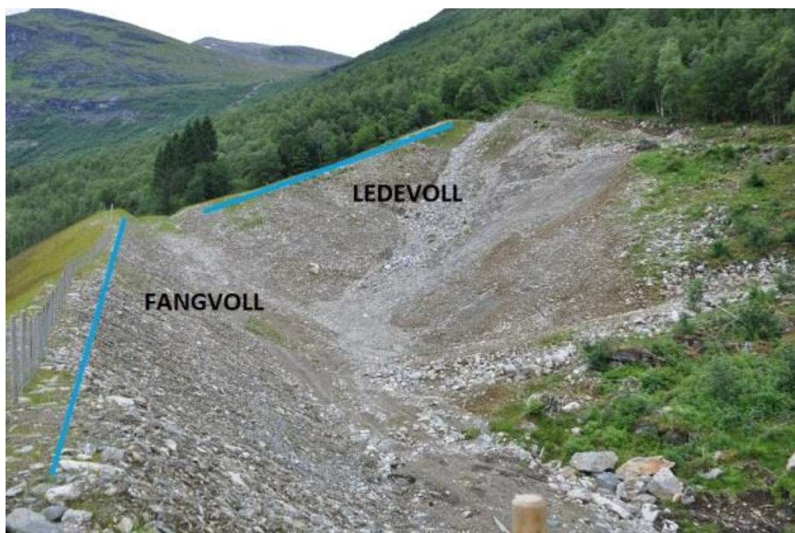
Figur 4-14 Fangvoll og ledevoll i system. Ved Fyrdsberg tunnelen på E39, 2013 (Foto: Marie Drågen Belland).
