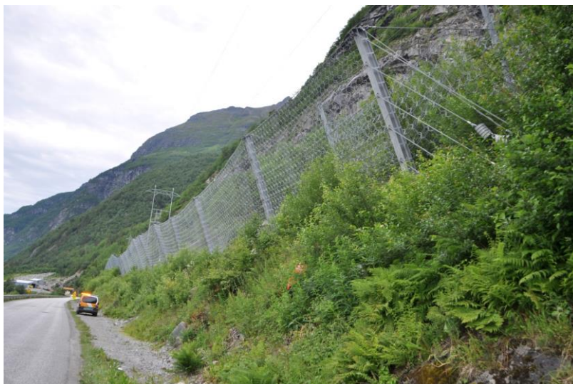
Figur 3-6 Fanggjerdar på Rv70 Oppdølstranda, 2013 (Foto: Marie Drågen Belland).
