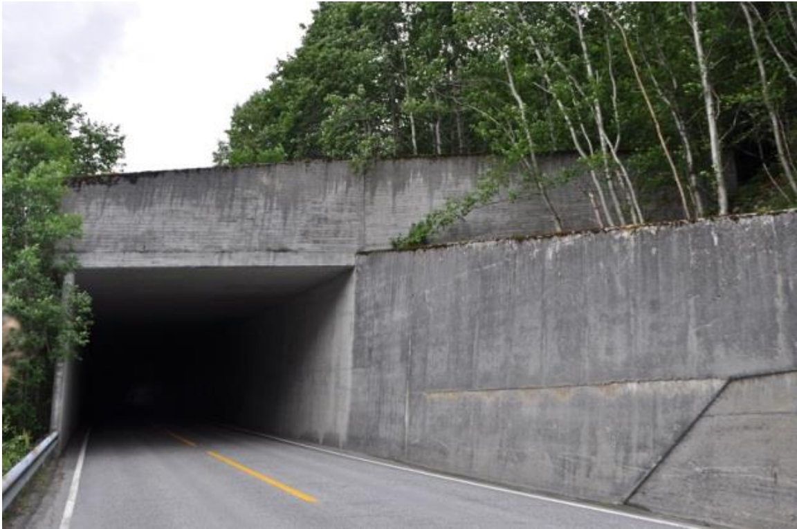
Figur 4-15 Skredoverbygg med forlenget ledevoll, Breidefonnoverbygget på E39 Stigedalen, 2013 (Foto: Marie Drågen Belland).
