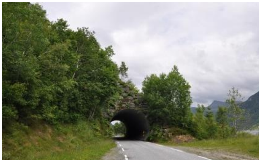
Figur 4-12 Rørtunnel fv40 Dalsfjordvegen, 2013 (foto: Kari Linn Søreide).
