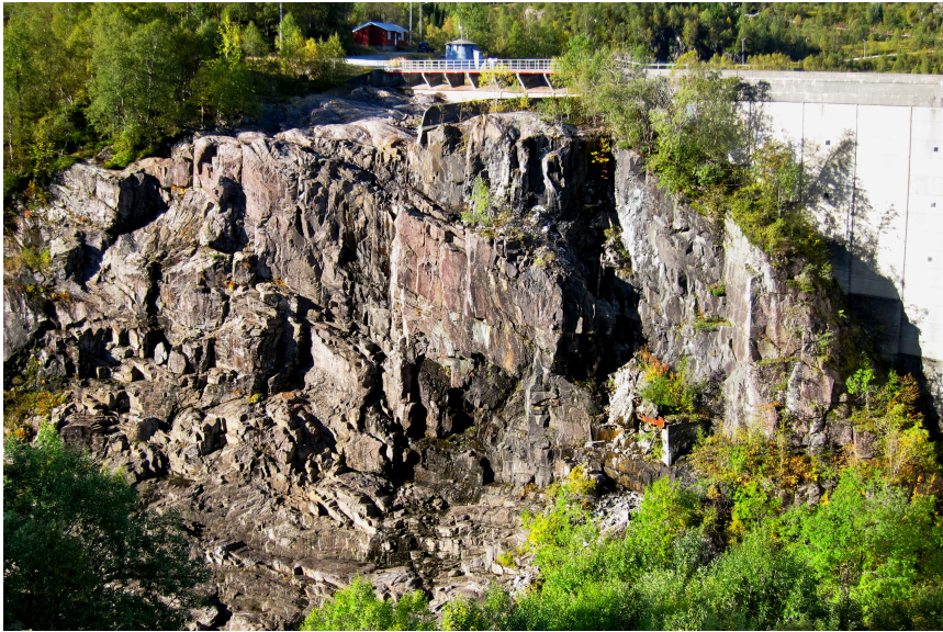
Figur 6.7: Bilde fra befaring høsten 2012.
