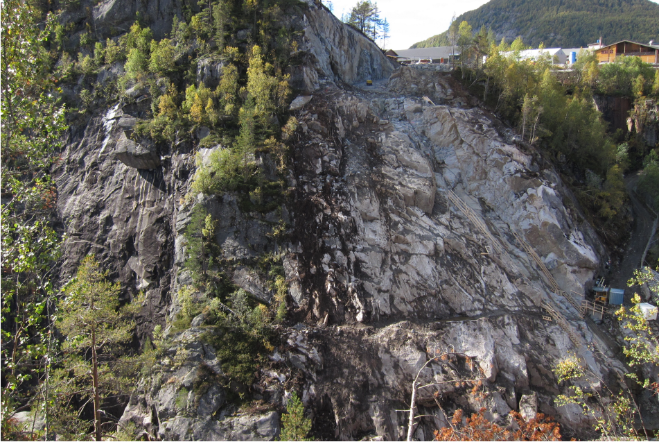
Figur 5.8: Oversikt over høyre vederlag (overheng til venstre i bildet).
