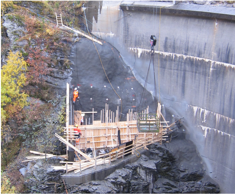
Figur 7.6: Sikring høsten 2012, sprøytebetong og ny betongplattning. Stag skal settes inn over boltene i bildet (Multiconsult, 2012k).
