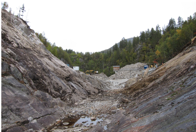
Figur 5.4: Damstedet sett fra nedstrøms.
