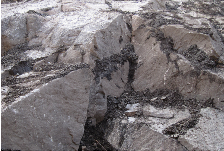
Figur 5.11: Kileutglidning i undergravd skrånning.
