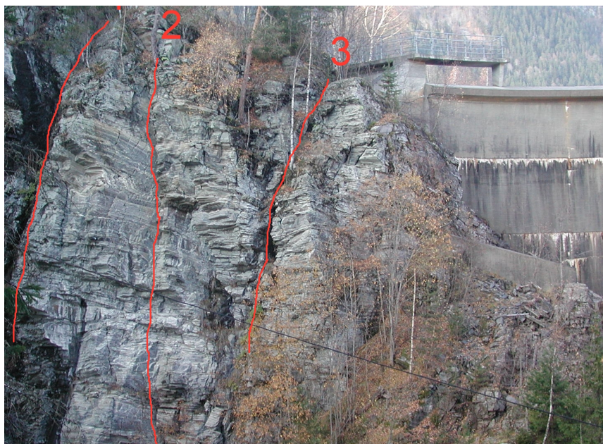
Figur 8.5: Hvordan bergmassen egentlig ser ut! Profil 2 er orientert omtrent vinkelrett på svakhetssonene som er markert i bildet. (Bilde fra Halvorsen, Multiconsult, 2012.)
