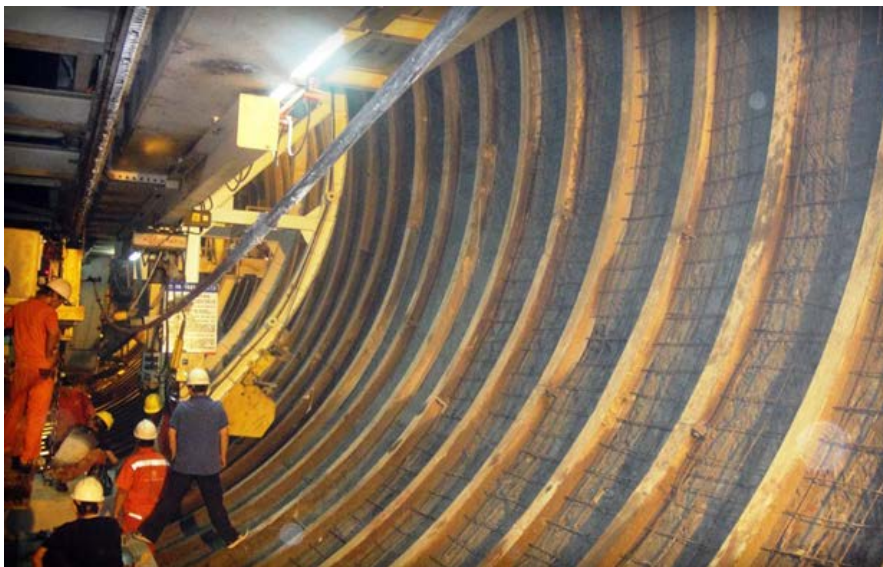
Figur 5-3 Ring av stålbjelker og stålnett blir installert (Robbins, 2013).
