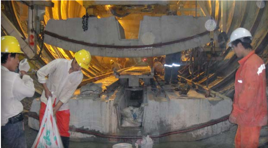
Figur 5-6 Installering av betongsegment i sålen ved West Quinling tunnel (Robbins, 2013).
