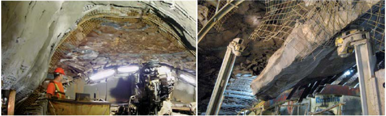
Figur 6-5 Bilde til venstre viser overmasser. Bilde til høyre viser en blokk som har falt ned på fingerskjoldet (Gschnitzer og Goliash, 2008).
