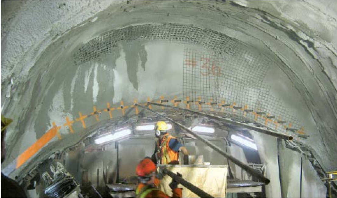
Figur 6-6 Installering av rørskjerm ved overmasser som overgår 2,5 m (Gschnitzer og Goliasch, 2008).
