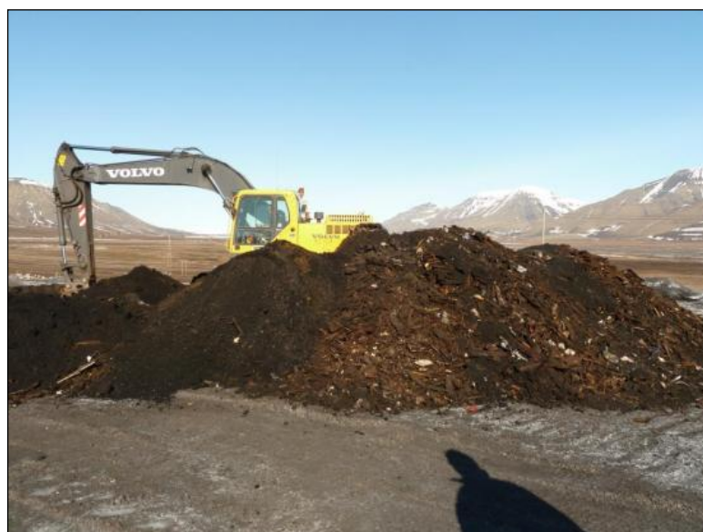
Figur 5-15: Slagg og treverk i den øverste meteren av deponiet.
