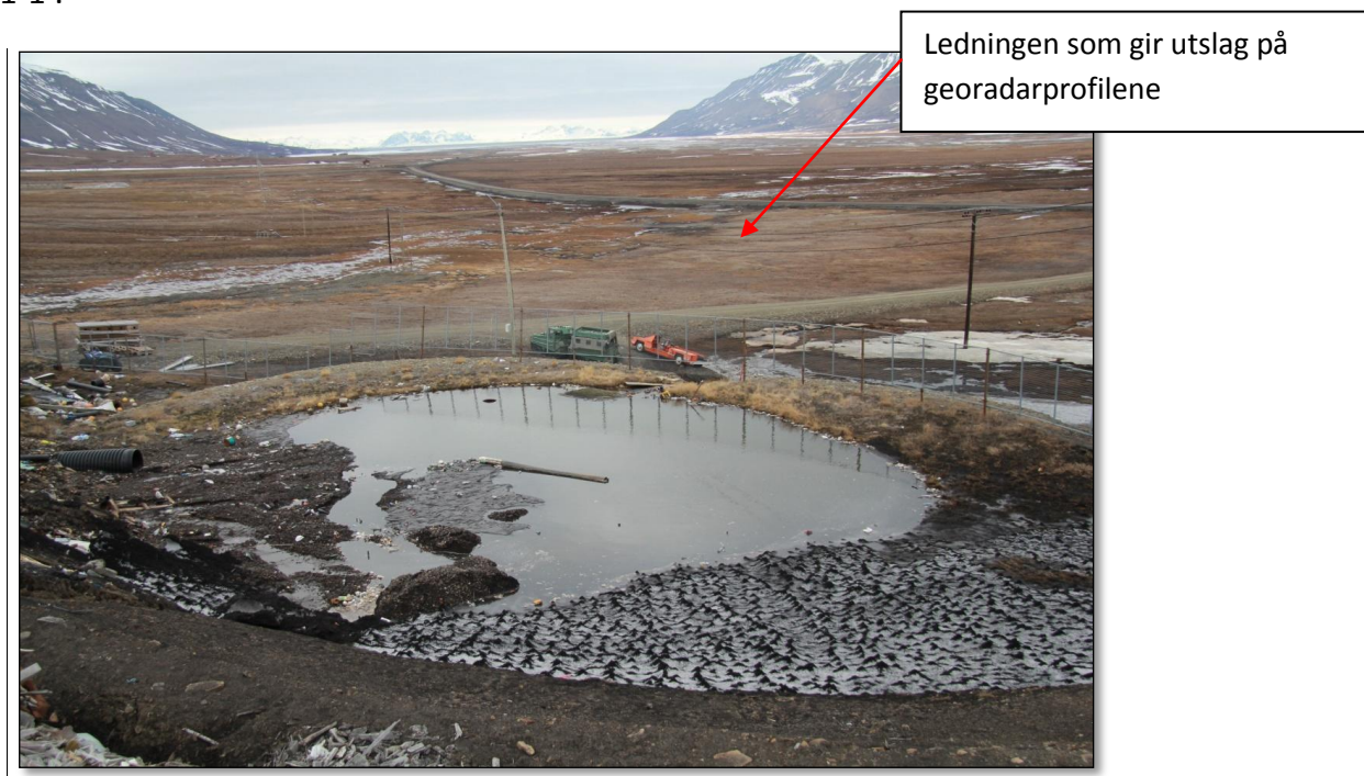
6-1: Ledningen som gir utslag på profilene som er tatt i nærheten. Bildet viser også sigevannsdammen i nedkant av deponiet. (Foto: Hågen Hatling)
