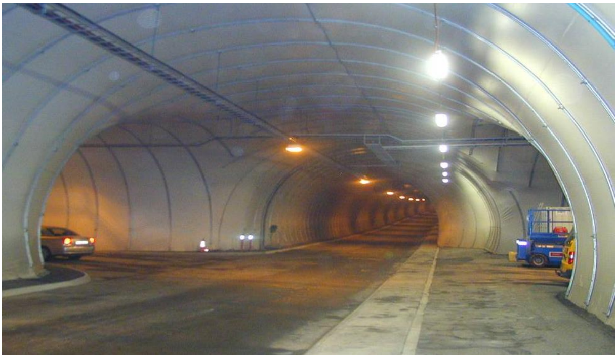
Figur 9-1 Bilder fra Melkøysundtunnelen, med helhvelv ((Giertsen Tunnel AS, 2012).
