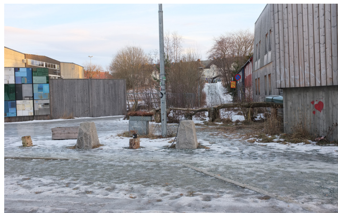
Nordtvedtsgate sett fra Strandveien i henholdsvis 1964 og 2015. Gateløpet og fondmotivet er bevart. Tilsvarende siktlinje i Sødemannsgate er også bevart.
