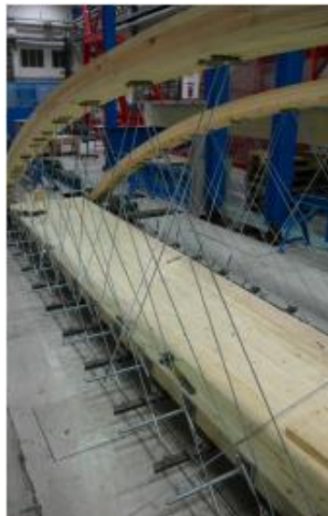
Figur 2.1 Strekkstag i nettverksbru hengt opp med skruer.
