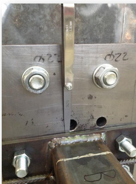
Figur 5. 7 Visuell sjekk av deformasjon i endeplaten. Forskyvningen er 0,75mm og enda innenfor elastisk sone.
