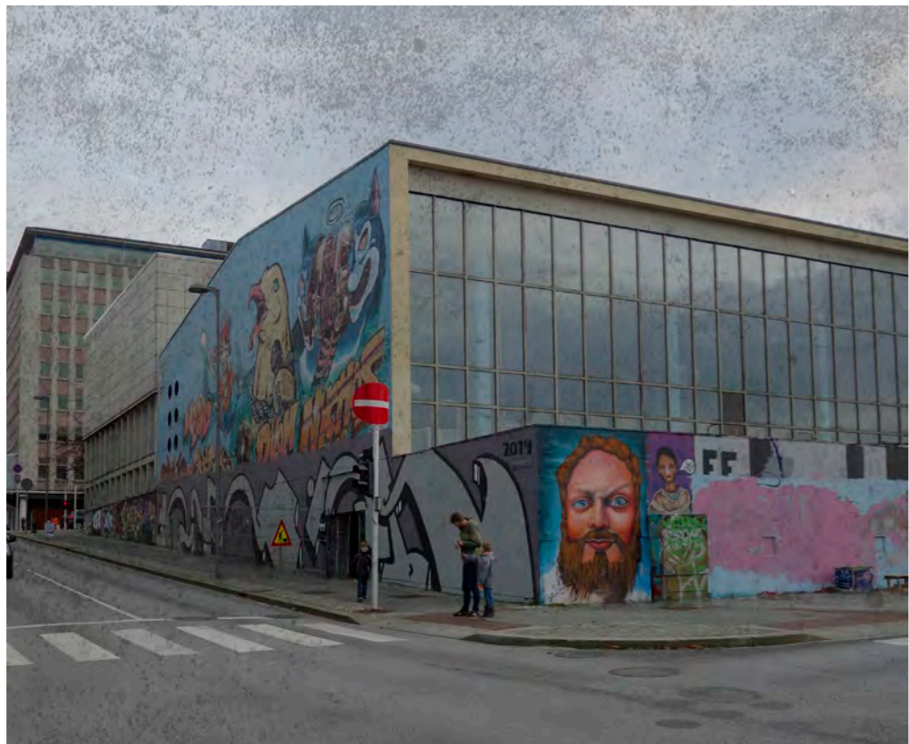
Eksiterende fasade med graffiti
