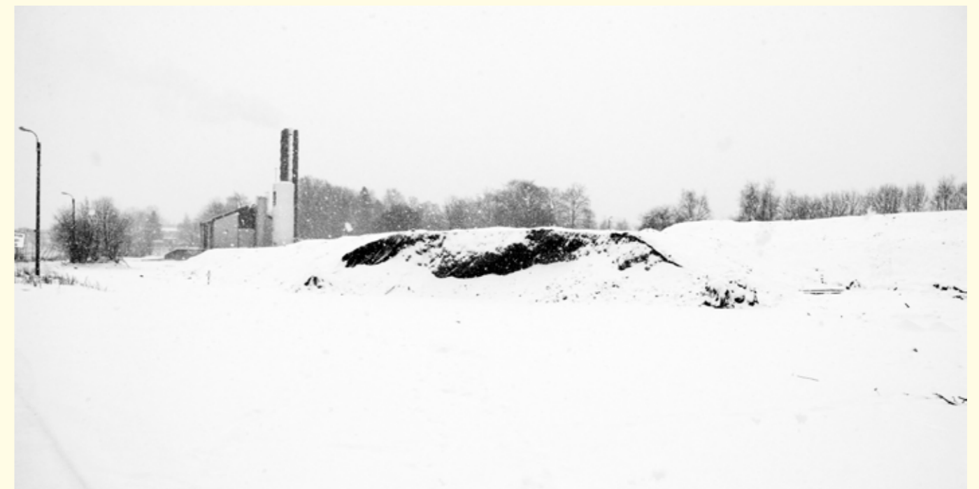
Fjernvarmeanlegget og betongrester i Ladedalen
