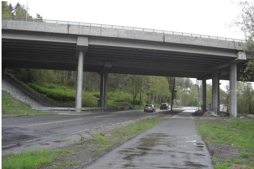
Figur 1.1 Bilde av Ny Klemetsrud bru (foto O.Hermundsdal)
