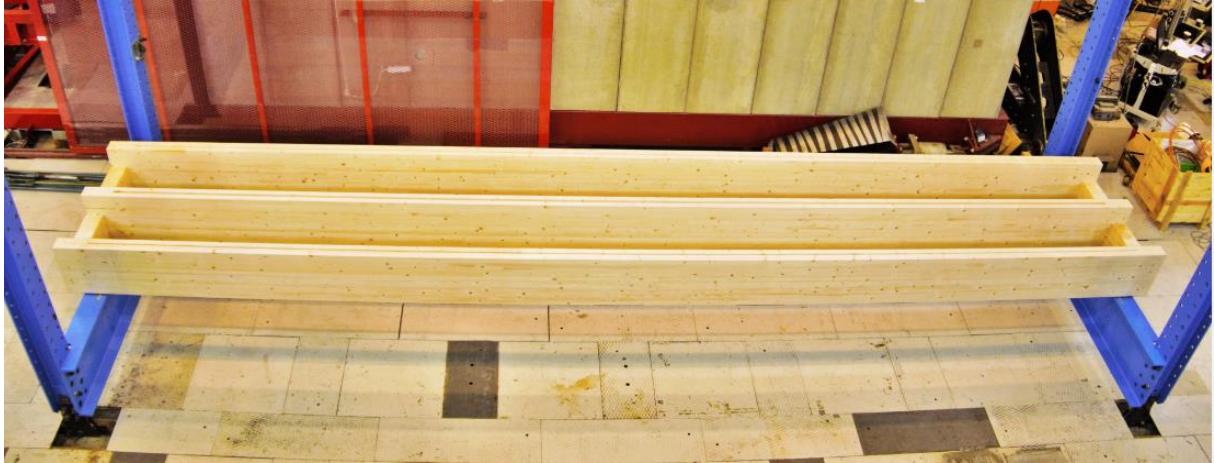
Figur A.13 Limtrebjelker lagt opp og klar til montering av betongplater
