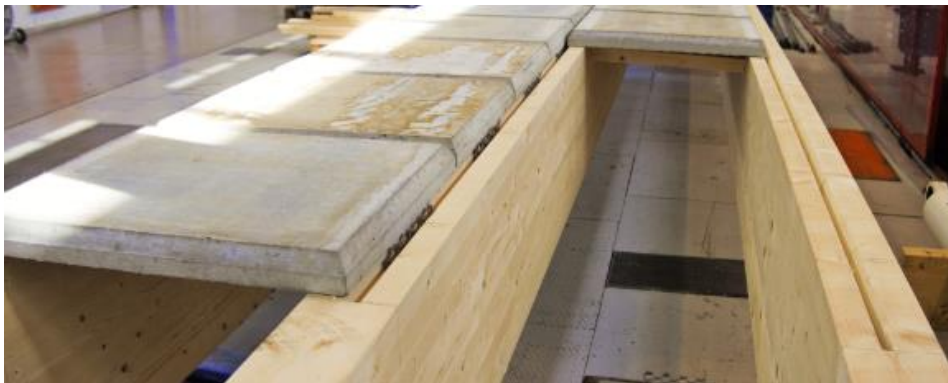
Figur 6.7 Bilde fra monteringsfasen med skjærforbinderens plassering i limtrebjelkene
