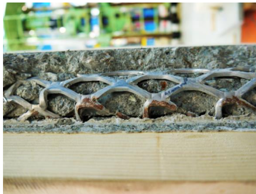
Figur 5.16 Mapepoxy L-Mørtel nr. 2, bruddform på skjærforbinder
