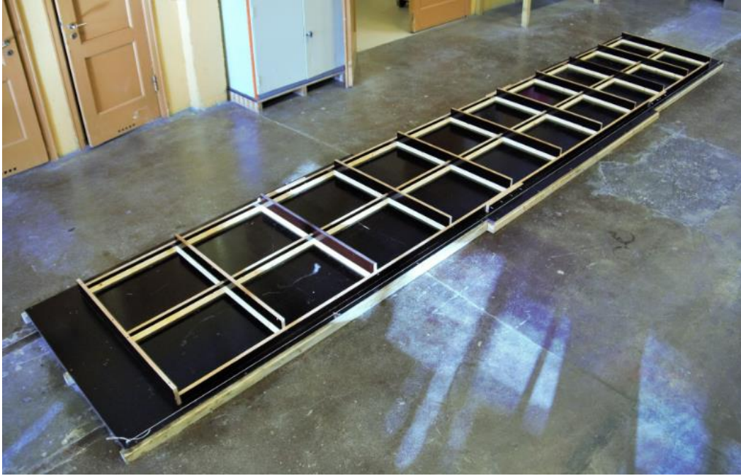
Figur A.9 Forskaling til betongplater
