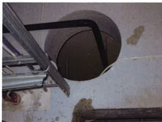
Figur 1: Brennbart skum brukt som branntetting Figur 2: Gjennomføring unødvendig stor og uttettet
