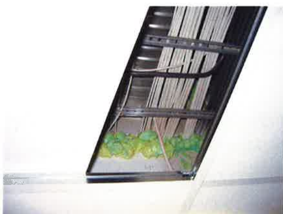
Figur 3: Brennbart skum brukt som branntetting Figur 4: Branncellevegg er ikke ført opp til tak
