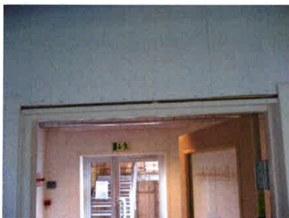
Figur 6: Brandør er ikke branntettet under listverk
