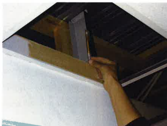
Figur 3: Brennbart skum brukt som branntetting Figur 4: Branncellevegg er ikke ført opp til tak
