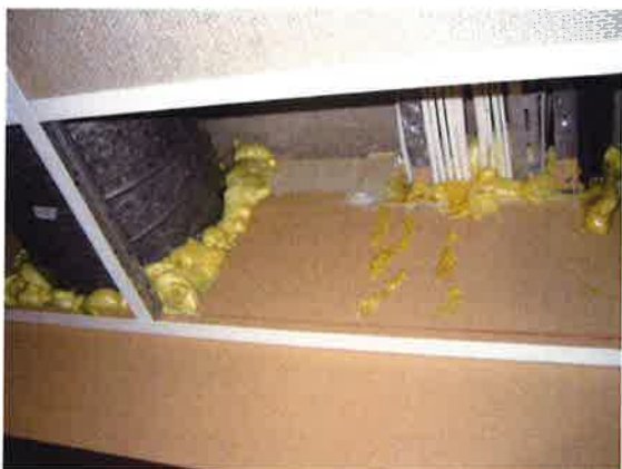
Figur 1: Brennbart skum brukt som branntetting Figur 2: Gjennomføring unødvendig stor og uttettet
