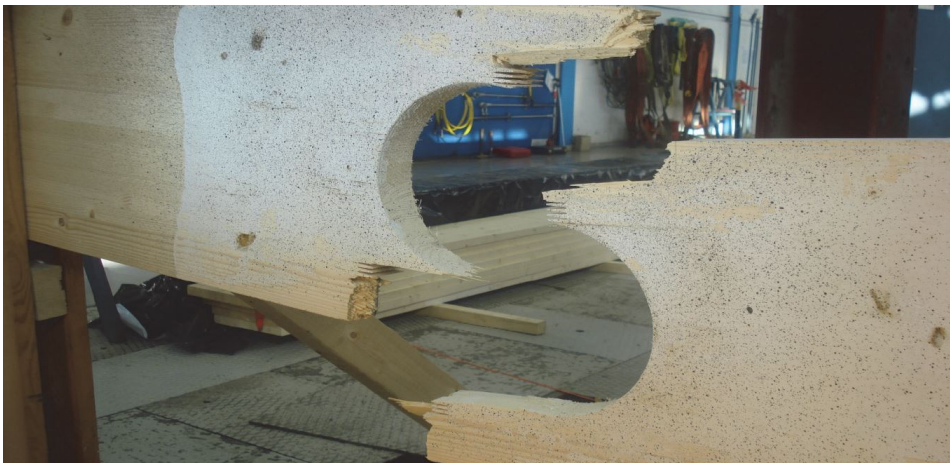
Figur 4.15: Brudd som følge av langsgående strekkspenninger fra BMS170-serien utført av Solberg [17].
