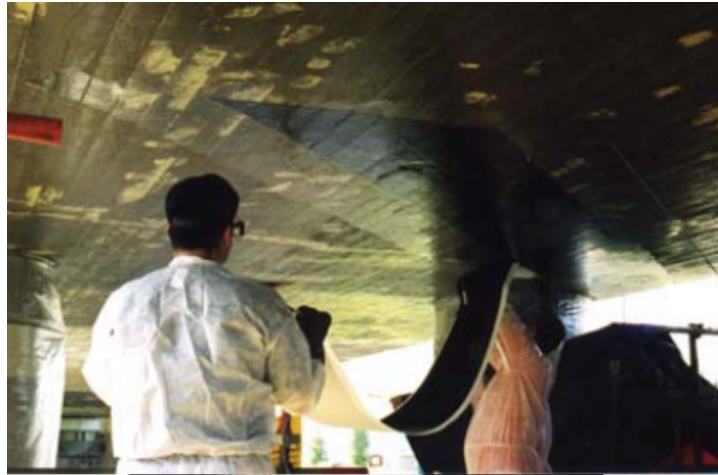
Figur 2.8 Wet lay-up-system med fibervev (Thorenfeldt et al., 2006).
