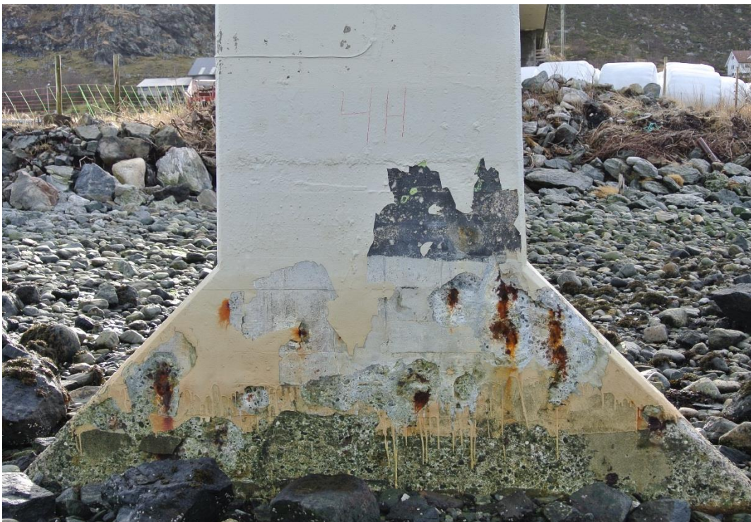
Figur 10.4 fundament akse 4 sett fra vest
