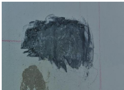
Figur 10.9 Pusset ned til betong
