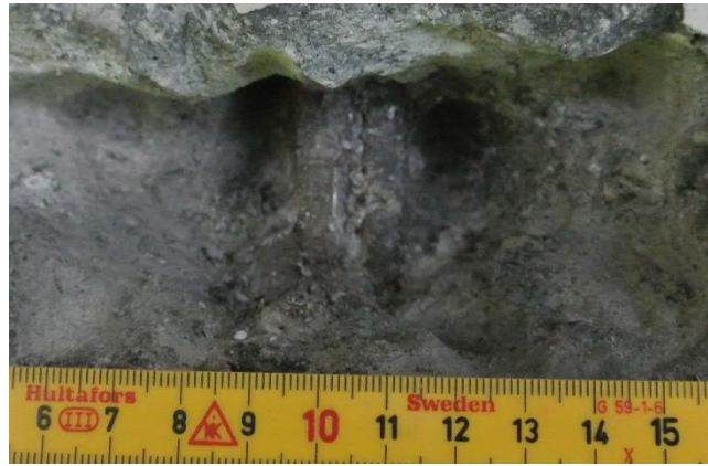
Figur 10.29 Bøylearmering på Nord-side 1 meter fra opplegg.
