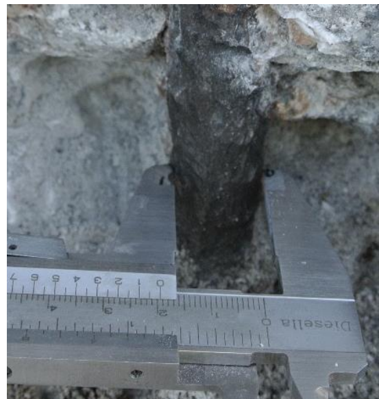
Figur 10.26 Armering i steinreir akse 5, før og etter pussing av korrosjonsprodukt
