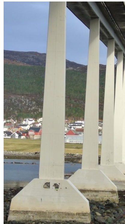
Figur 10.1 Søyle akse 5 og 6, sett fra øst.
