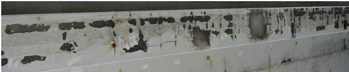
Figur 10.5 Brubjelke mellom akse 2 og 3, sett fra bakken
