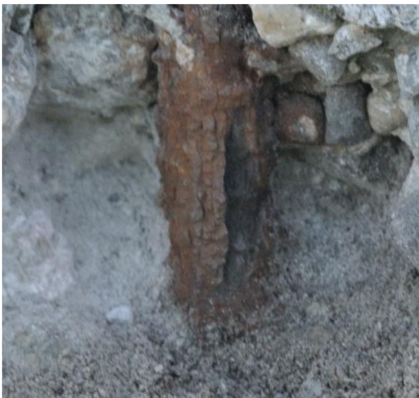
Figur 10.26 Armering i steinreir akse 5, før og etter pussing av korrosjonsprodukt
