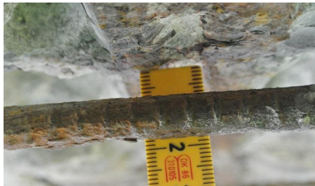
Figur 10.30 Avstand fra bøylearmering til lengdearmering
