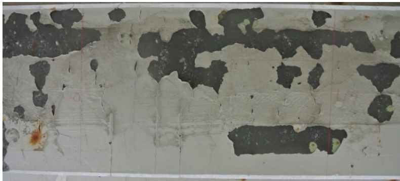
Figur 10.6 Brubjelke mellom akse 2 og 3, 5-6 meter fra akse 3
