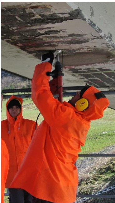
Figur 10.16 Uttak av kloridprøve
