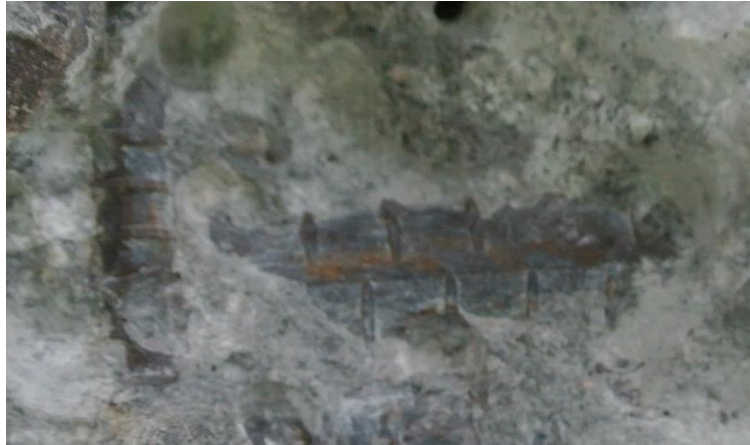
Figur 10.31 Lengdearmringing og bøyle i felt 9 m fra akse 3
