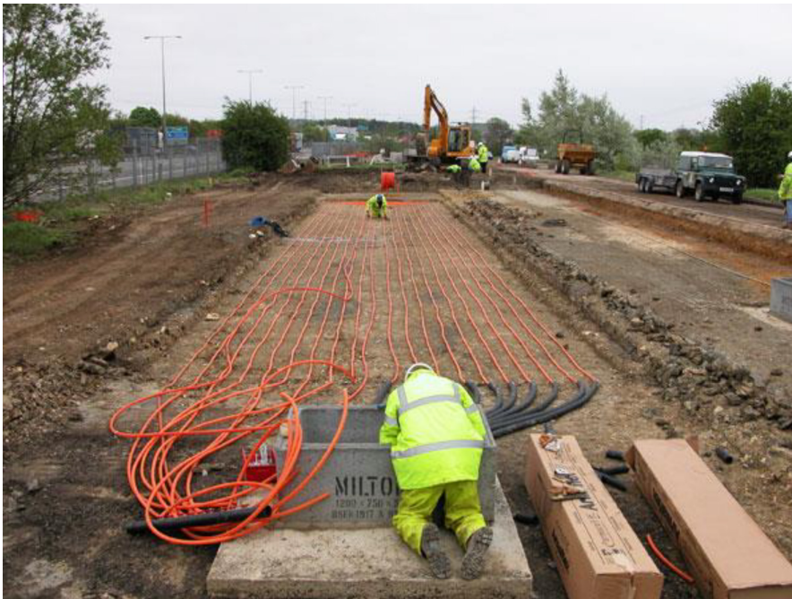
Figur 15: Bakkesolfangeren som legges på en motorvei i Toddington [22].
