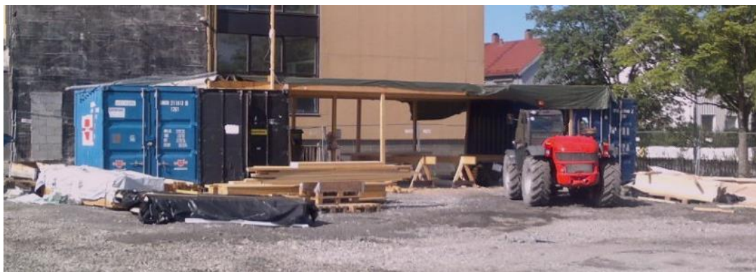
Figur 4.18 - Provisorisk arbeidsstasjon for å prefabrikere elementer. Foto: Joakim Dørum.
