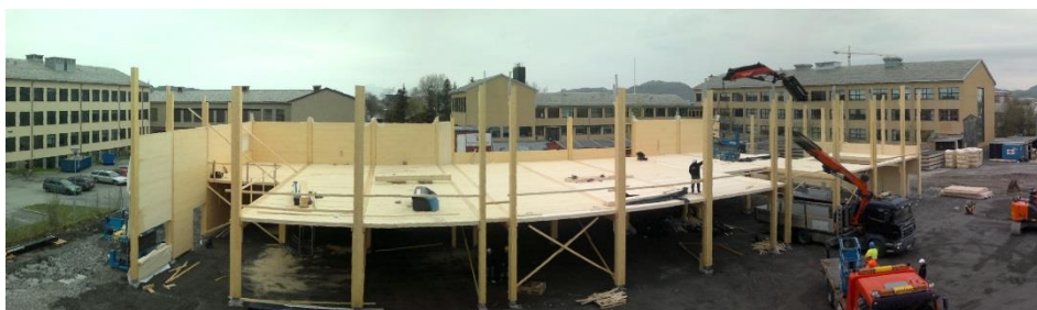
Figur 4.20 - Montering av massivtreskiver i etasjeskiller. Foto: Joakim Dørum.
