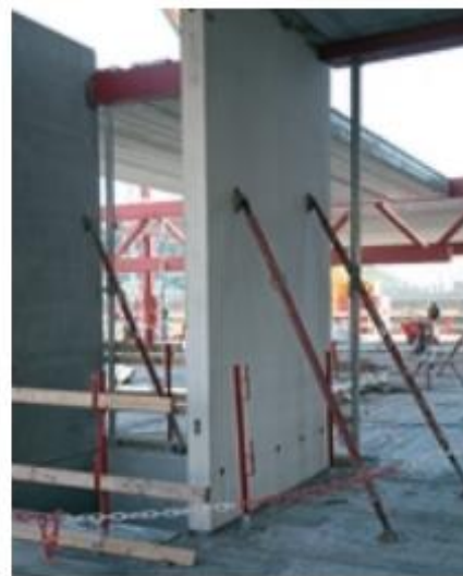
b) Avstivning av veggelementer.
