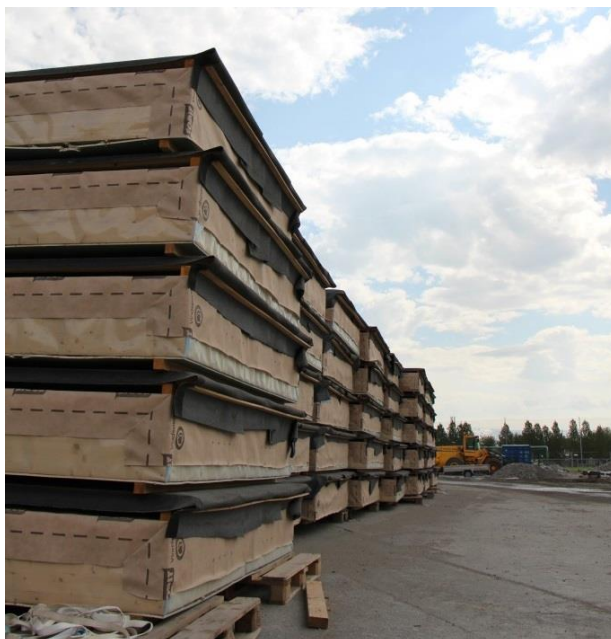
Figur 4.14 - Prefabrickerte takelementer klar for montasje. Foto: Joakim Dørum.
