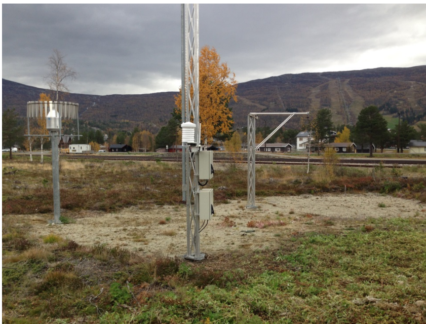
FIGUR 5-12 MÅLESTASJON BJORLI, BILDE TATT I MOT NORD (JBV).
