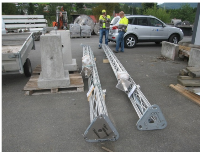
FIGUR 5-1 FUNDAMENTER OG GITTERMAST TIL MÅLESTASJON FØR MONTERING (JBV).
