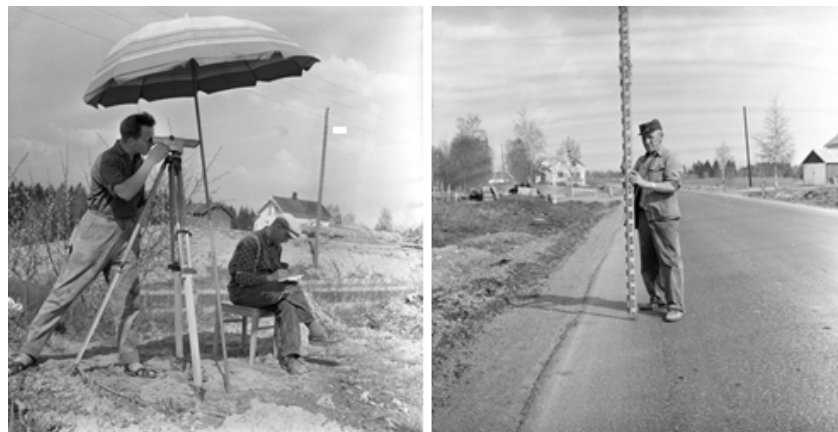
Figur 4: Landmåling med kikkert og målestang (Landmåling, fotografi). 2015)
