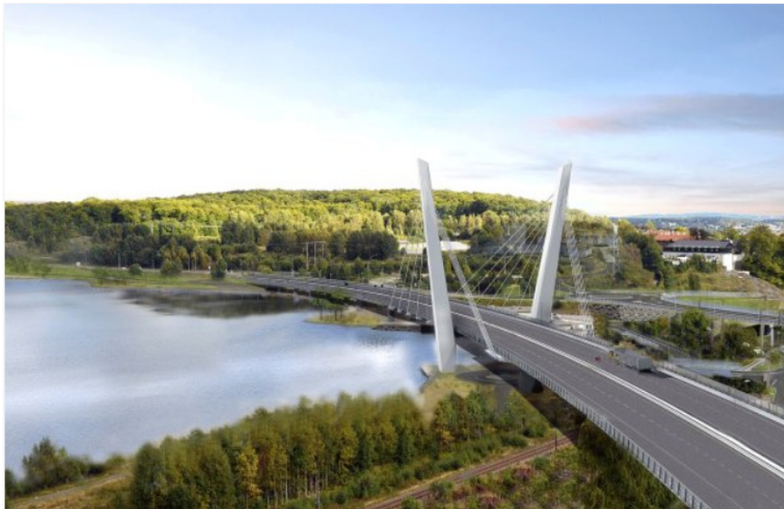
Figur 1: Farris brua, som en egen entreprise i prosjektet "E18 Bommestad-Sky" (Rambøll, 2014)
