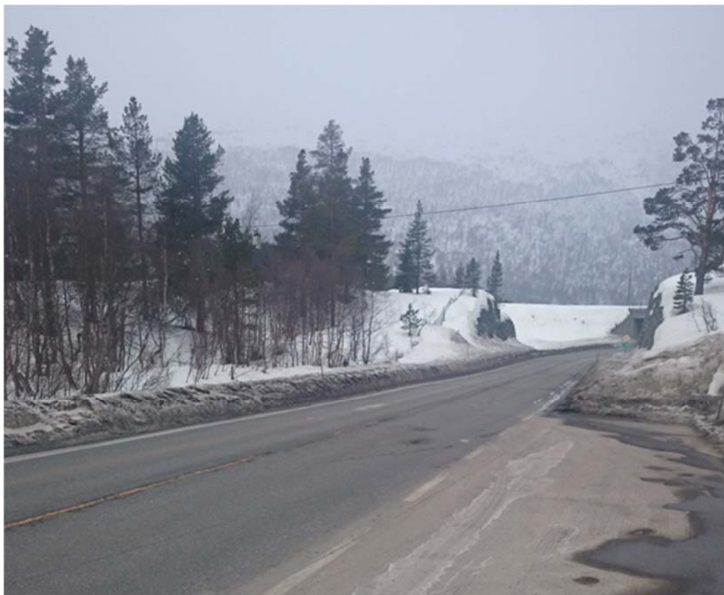
Figur 15. Bilde av vegen ved Brøstvegen kl. 1245, i retning Åndalsnes. Vegen er bar og tørr.
