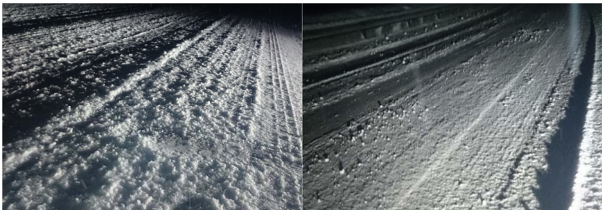
Figur 20. Til venstre: Tilstand på DkC veg mellom Brøstvegen og Bjorli, 05Ev136 hp5 11670m. Til Høyre: Tilstand på DkB veg nedover Brustuglia, 15Ev136 hp1 3670m.
