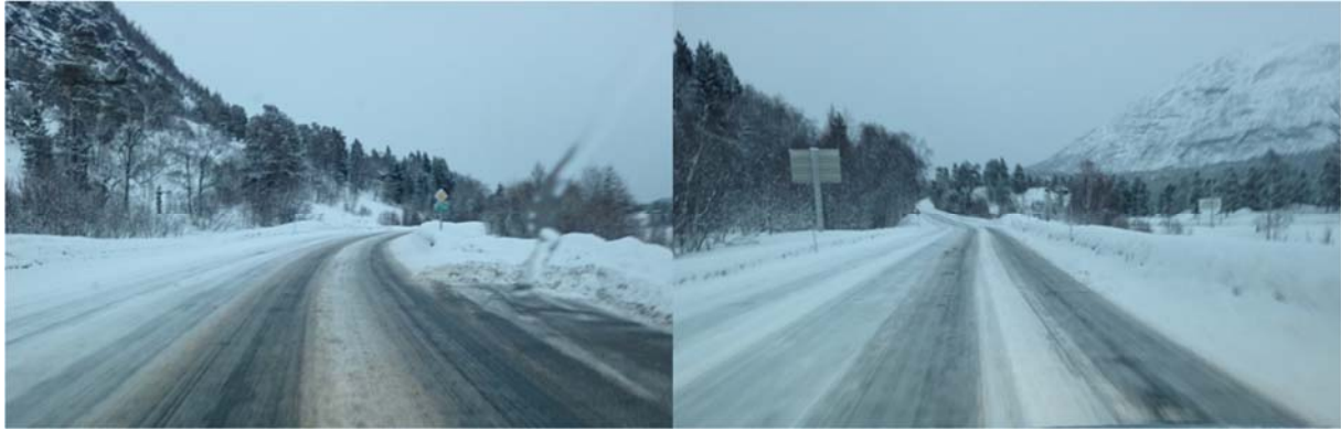
Figur 17. Til venstre: Bilde tatt ved kontraktsgrense kl. 1718. Viser overgang fra DkB veg til DkC veg. Til høyre: Bilde tatt etter ca. 220 meter inn på DkC veg.
